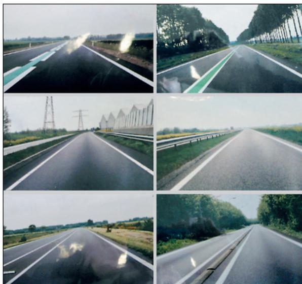
Bild 39: Gestaltungsvarianten der through roads (stroomweg); (Bilder zur Verfügung gestellt von HAGENZIEKER, 2016)
