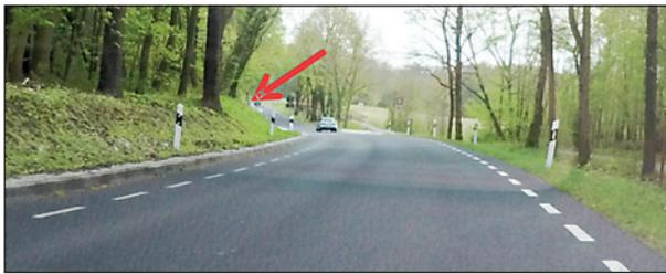
Bild 110: K 6908 – eingeschränkte Erkennbarkeit der Haltstelle und des Knotenpunktes in Fahrtrichtung Ferch
