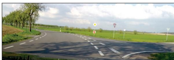
Bild 117: S 47 – Knotenpunkt ohne Fahrbahnteiler in der untergeordneten Zufahrt und ohne LA 4
