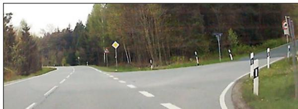
Bild 97: S 95 – Anbindung der K 6211 ohne Fahrbahnteiler in der untergeordneten Zufahrt
