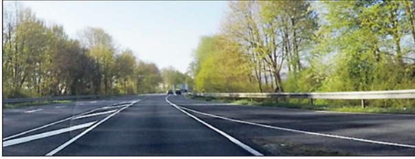
Bild 87: B 3 – KP 4 Richtung Süden – Fahrstreifenaddition Sichtproblem
