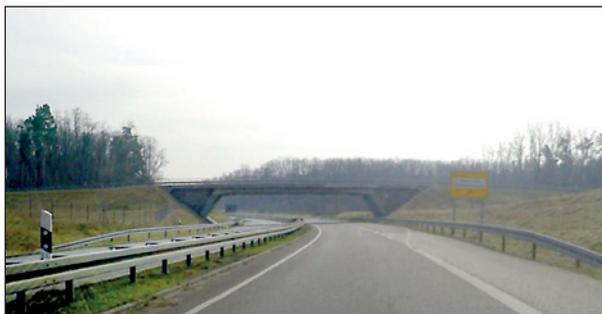
Bild 72: B 112 – Begünstigung erhöhter Aufmerksamkeit im Knotenpunktbereich durch Anordnung einer passiven Schutzeinrichtung im Mittelstreifen
