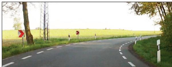
Bild 114: S 47 – Verkehrszeichen Z 625 StVO Richtungstafeln in Kurven mit  $R < 200\text{ m}$
