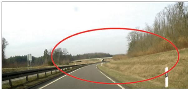
Bild 70: B 112 – subjektiv wahrgenommene, geringe Sichtweite innerhalb einer Rechtskurve im Streckenverlauf
