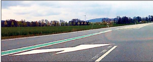
Bild 75: B 178n – Markierung der Pfeile und der Sperrfläche bei kritischen Wechseln
