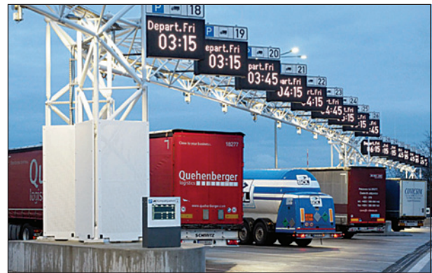
Fig. 1-1: Compact Parking [ZVM: Autobahndirektion Südbayern, Zentralstelle Verkehrsmanagement]
