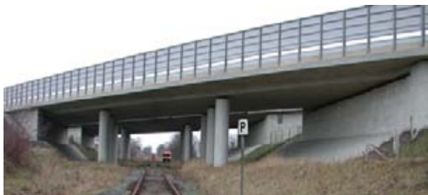
Bild 1-27: Plattenbrücke Helmstedt-Oebisfelde (A2) [SIB-04]
