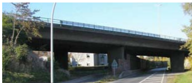
Bild 1-60: Plattenbalkenbrücke bei Rüningen in der Ansicht [SIB-04]
