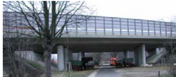
Abb. 34b: Schiefe Plattenbrücke
