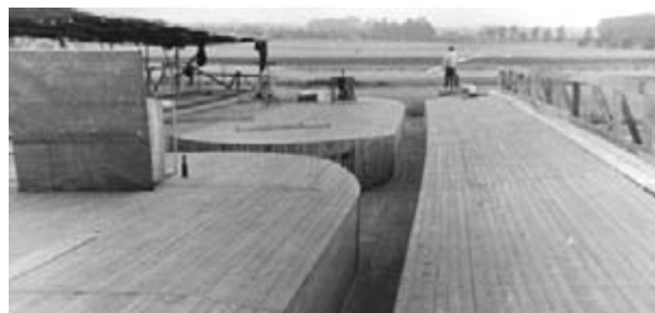
Bild 1-63: Überbauschalung, Bereich der Querträger [Originalfoto der Bauwerksunterlagen]
