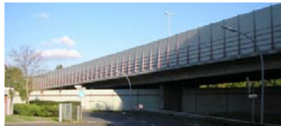
Abb. 34d: Längs vorgespannte Plattenbalkenbrücke
