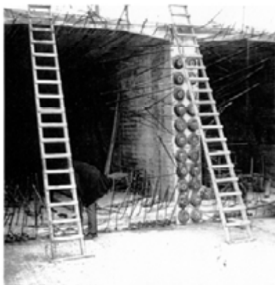
Bild 6.4: Koppelfugenquerschnitt eines älteren Spannbetonüberbaus
