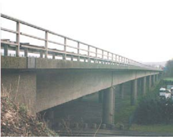
Bild 1-51: Plattenbalkenbrücke Bissendorf in der Ansicht [SIB-04]
