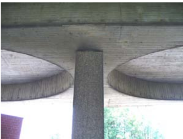
Bild 1-85: Ausbildung der Mittelquerträger über der Stütze
