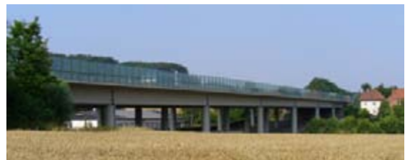
Abb. 34c: Längs und quer vorgespannte Plattenbalkenbrücke
