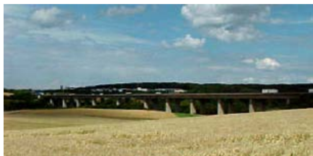
Bild 1-9: Brohltalbrücke gesamt als Seitenansicht [SIB-04]
