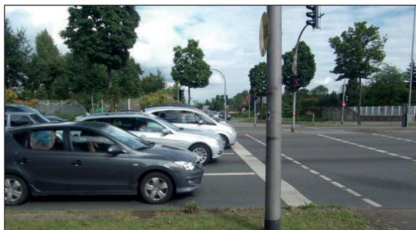
Bild 19: Komplexer Knotenpunkt mit möglicher Verdeckung von Fahrstreifen
