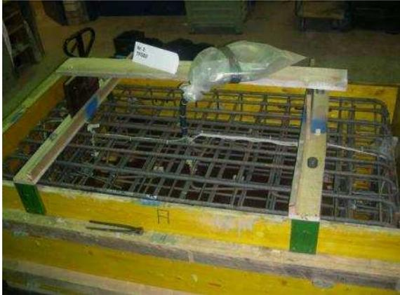
**Bild 37** Schalung der Probekörper für die Tunnelchalensegmente der geschlossenen Bauweise
