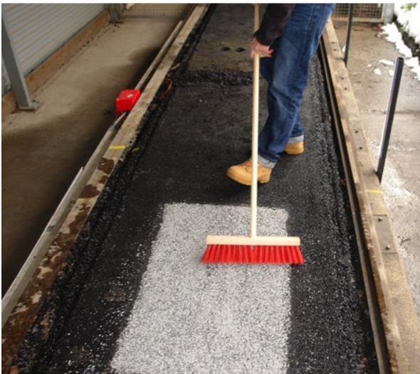
Bild A 9: Auftragen des Streugutes und Abtragen des überschüssigen Streugutes (nach 24-stündiger Aushärtung des Bindemittels)
