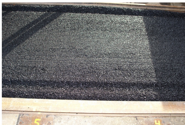
Bild A 5: Einbaustrecke nach Asphalteinbau
