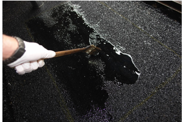
Bild A 8: Gleichmäßiges Verstreichen des Bindemittels
