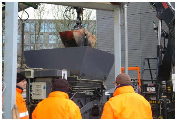
Bild A 2: Die Asphaltmischgutlieferung
