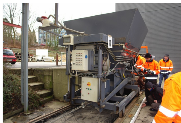
Bild A 4: Der Fertiger
