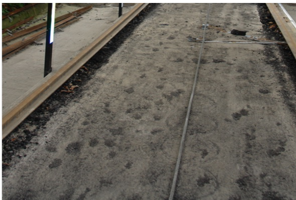
Bild A 1: Untergrund der Einbaustrecke
