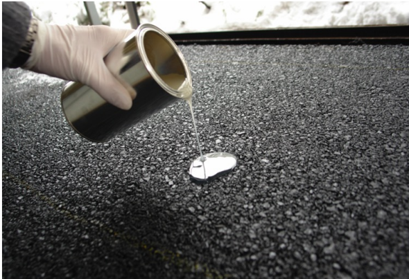
Bild A 7: Auftragen des Bindemittels
