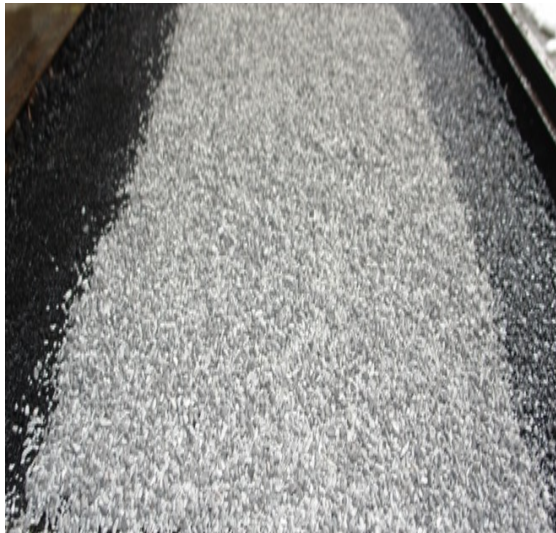
Bild A 10: Endzustand
