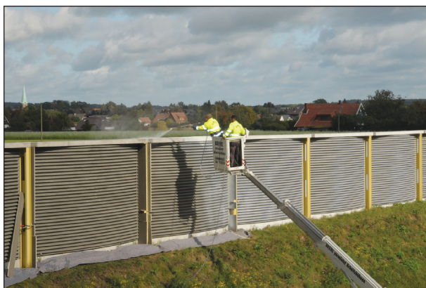
Bild 4.3: Beschichtungsarbeiten an der Lärmschutzwand an der A 1
