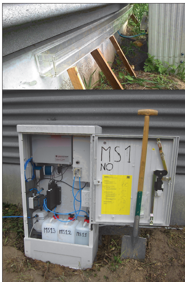
Bild 4.14: Auffangvorrichtung (oben) und Messcontainer (unten) für die Untersuchungen zur Nitratbilanzierung
