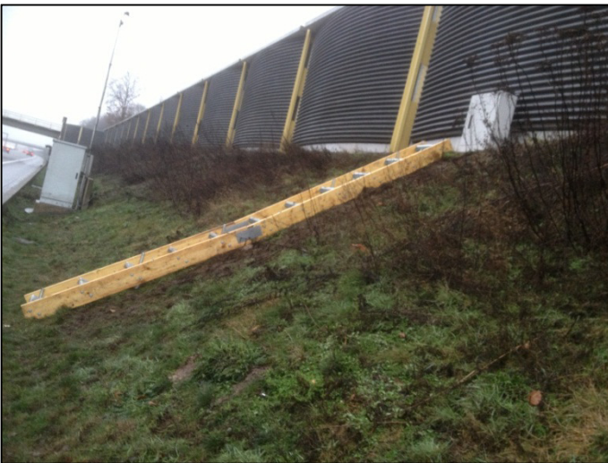
Abb. 2.5 Standort MS2, beschichteter Bereich
