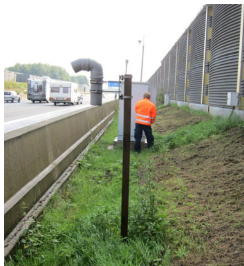
Bild 8: Standort Nord , Messstation NE1 , an der beschichteten Teilstrecke innerhalb der Lärmschutzwand, Blickrichtung Nordosten.
