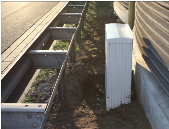
Abb. 2.7 Standort MS4, unbeschichteter Bereich
