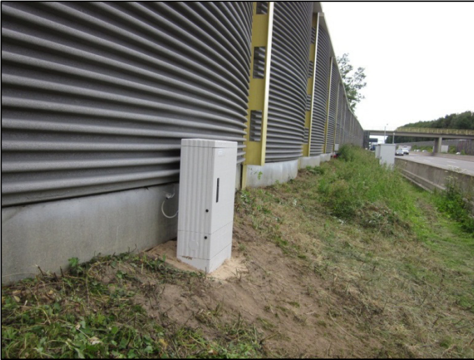
Abb. 2.4 Standort MS1, beschichteter Bereich
