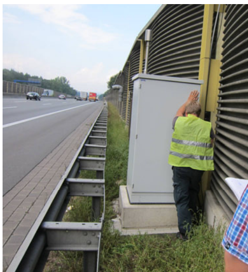
Bild 5: Standort Süd , Messstation SW1 , an der unbeschichteten Teilstrecke innerhalb der Lärmschutzwand, Blickrichtung Südwesten.
