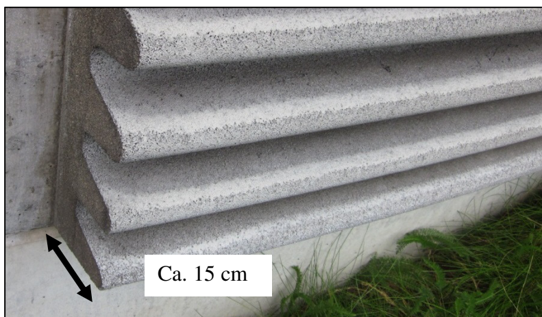
Abb. 2.1 poröser Betonkörper der Lärmschutzwand
