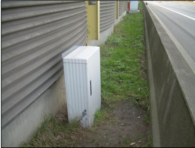
Abb. 2.6 Standort MS3, unbeschichteter Bereich
