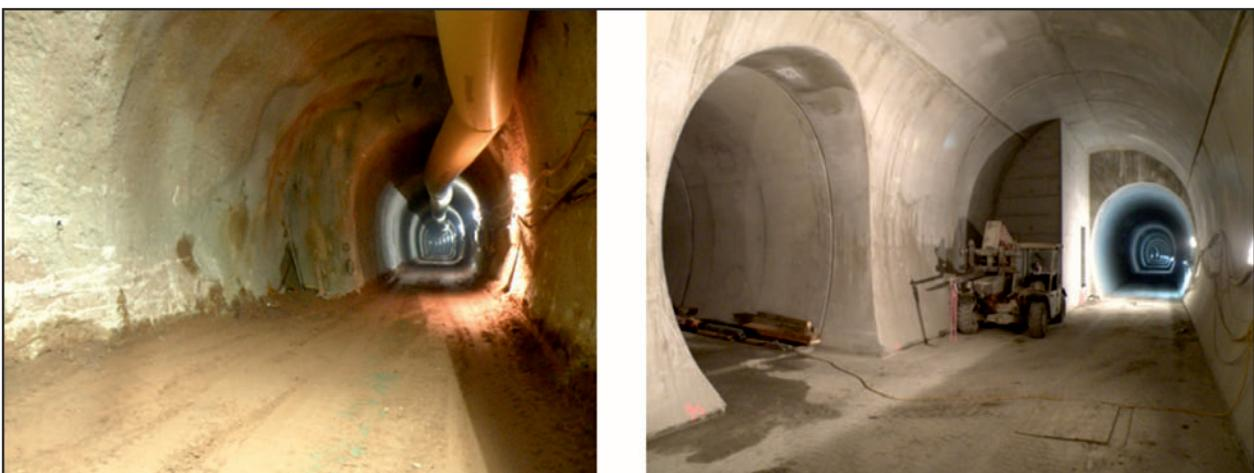
**Bild 2:** Neubau paralleler Rettungsstollen (links: 1-schalige Bauweise, begehbar, rechts: 2-schalige Bauweise, befahrbar) [Quelle: Hessen mobil]
