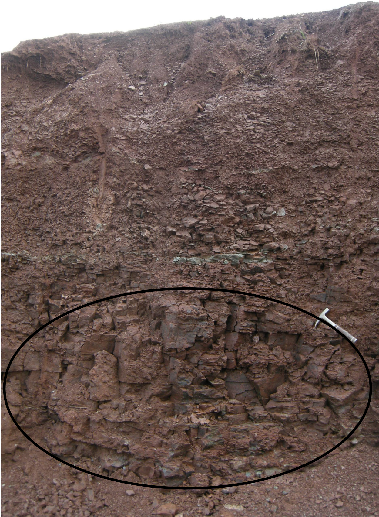
Bild 3 / A-3: Detailfoto Entnahmebereich
