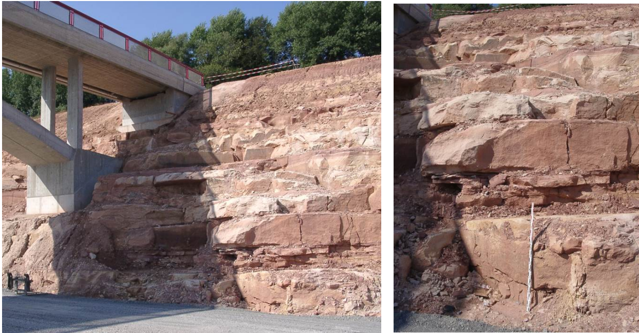
Bild 4 / A-4: Herauslösen von Gesteinsbrocken mit Kantenlängen > 2,0 m mittels Sprengen (im Bild dargestellt ist die gesprengte Böschungsoberfläche)
