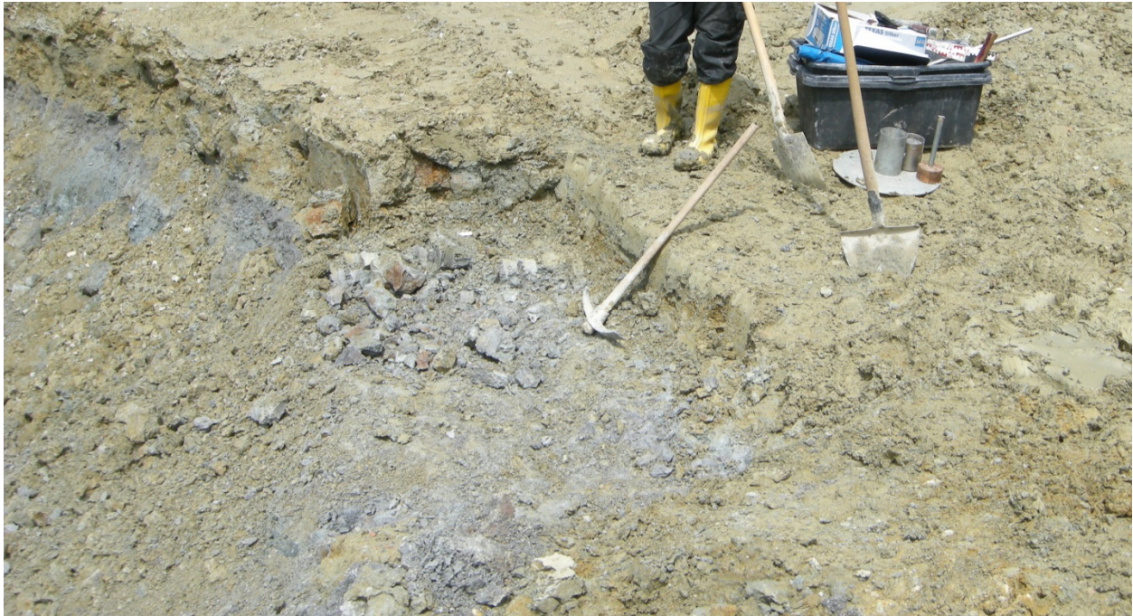
Bild 6 / A-1: Entnahmestelle nach Schurf (vor Probenentnahme)
