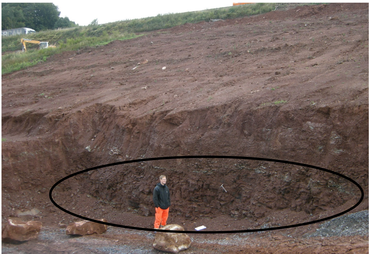
Bild 2 / A-3: Böschungsanschnitt – Bereich Probenentnahme schwarz markiert
