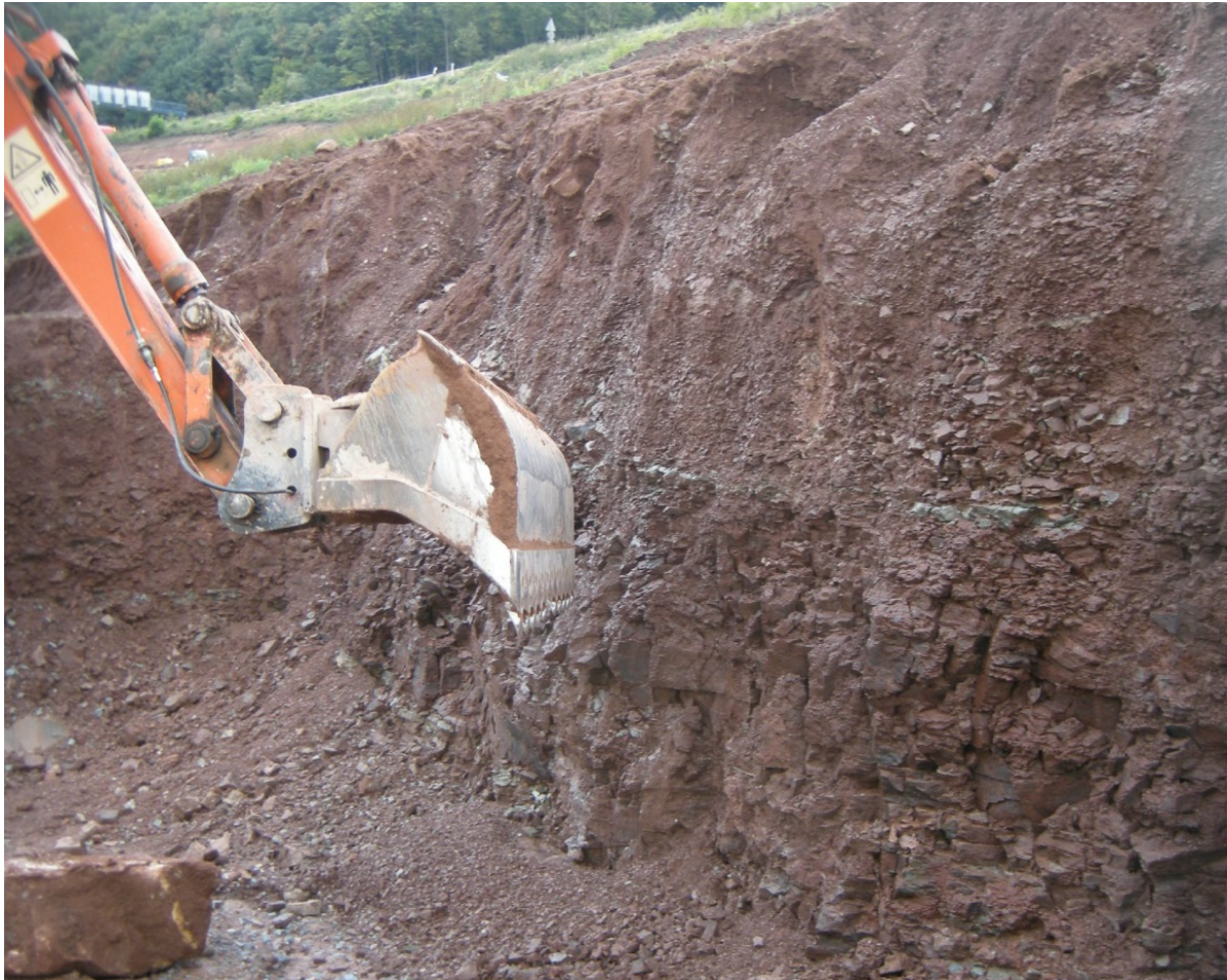
Bild 4 / A-3: Herauslösen von Gesteinsbrocken mittels Bagger
