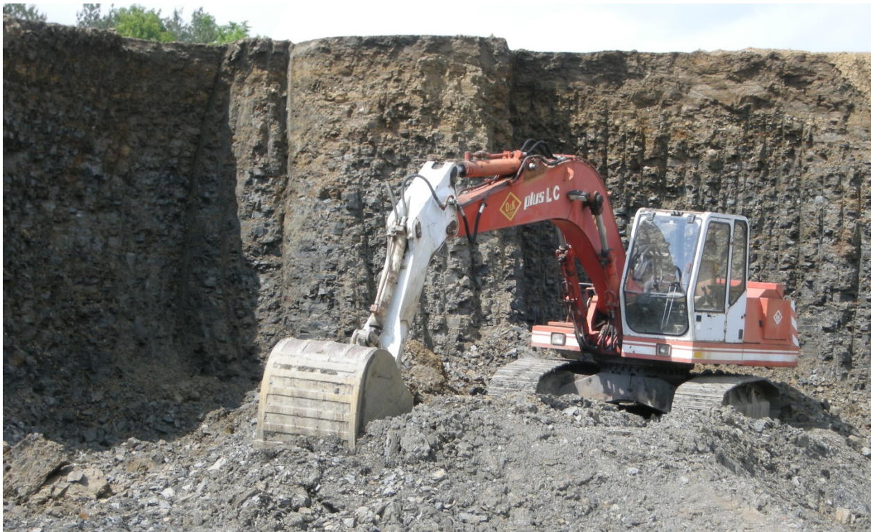
Bild 2 / A-2: Abbauwerkzeug: Bagger, Baggerschaufel mit Reißzähnen
