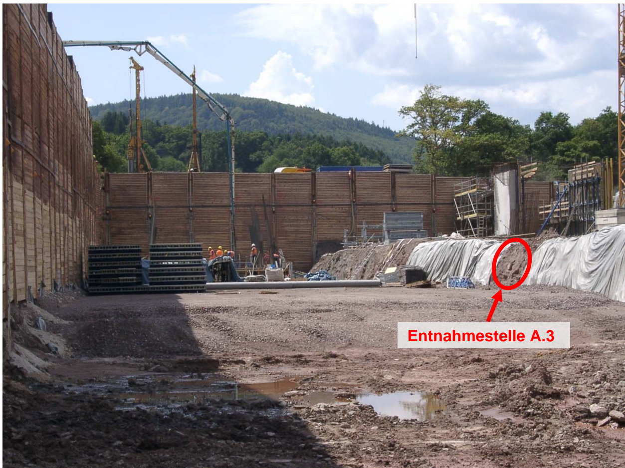
Bild 2 / A-6: Teilbereich Entnahmestelle A (A.3) im Trogtal zwischen Tunnel Metzberg und Tunnel Hirschberg mit Blick auf das im Bau befindliche Portal des Tunnels Metzberg
