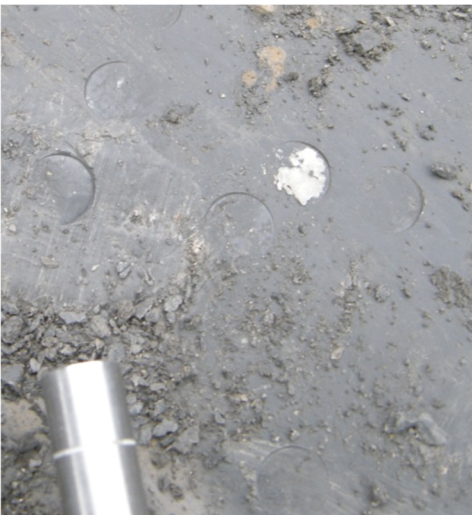
Bild 11 / A-2: Taschenpenetrometer: keine Eindringung möglich
