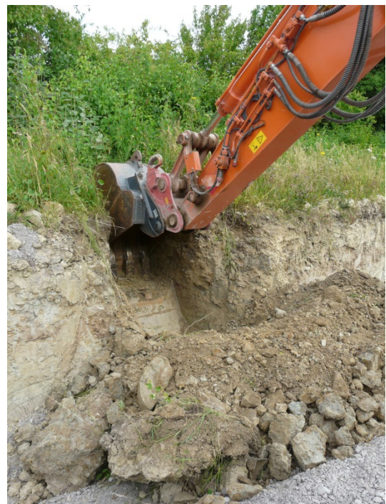
Bild 5 / A-7: Entnahmestelle 3 (ca. 2+130 Bau-km): Mergel (halbfeste bis feste Tone); vor Baggeraushub
