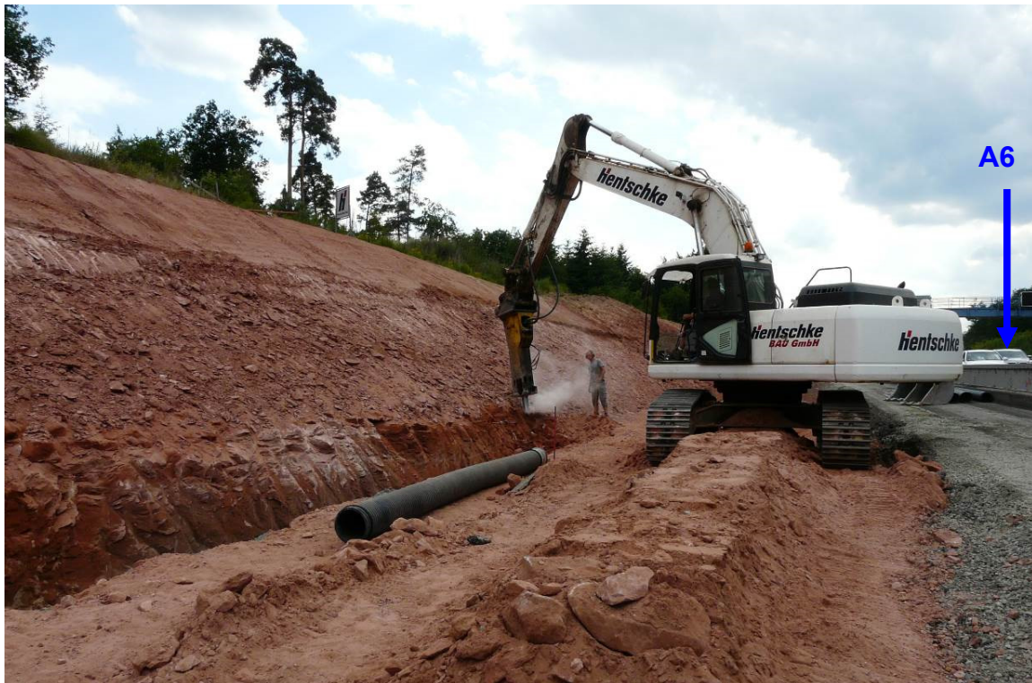
Bild 1 / A-5: Abbauwerkzeug im Felsbereich zur Vorzerkleinerung: Meißel
