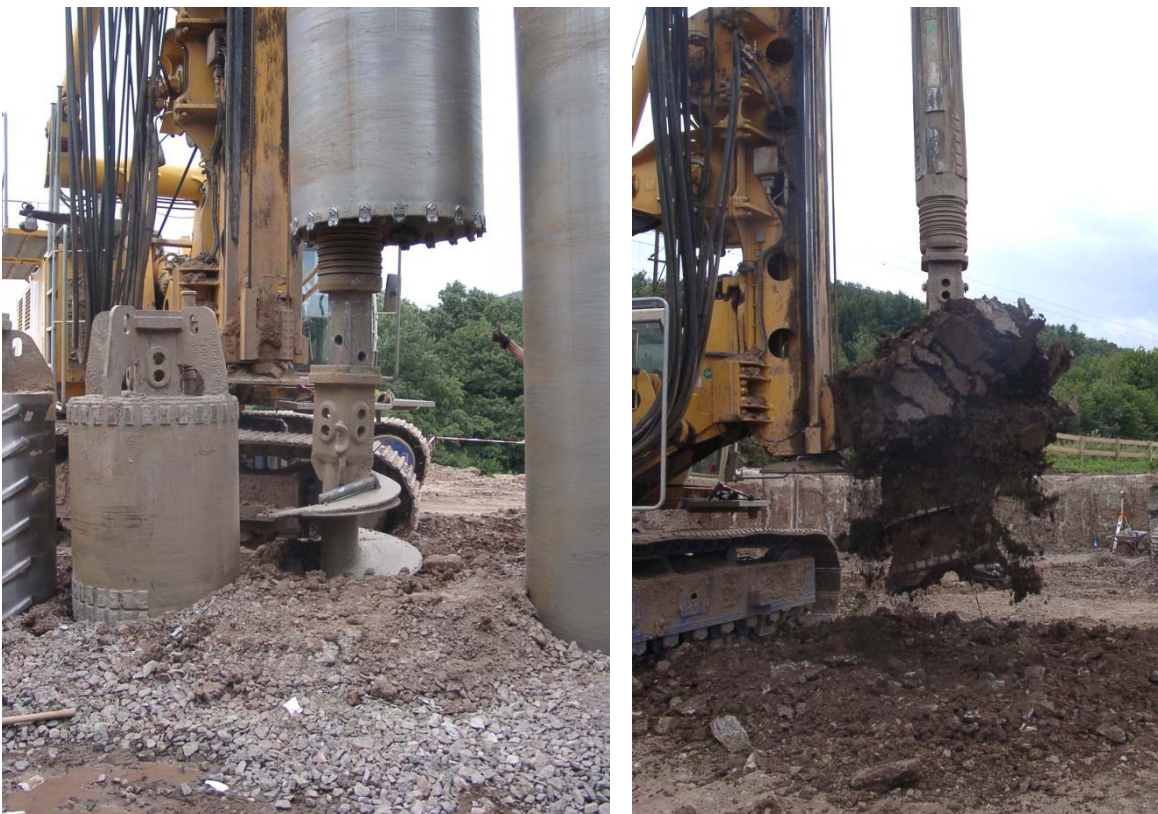
Bild 4 / A-6: Teilbereich Entnahmestelle B, Materialentnahme aus Schneckenbohrung – Tiefe 5,5 m (zur Herstellung der Bohrpfehlwand), Tunnel Metzberg
