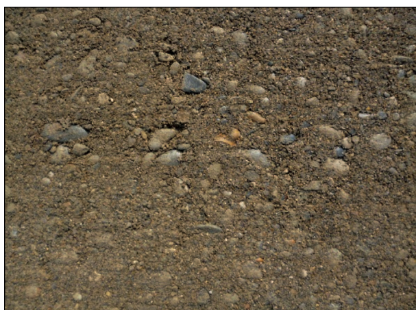
Bild 7: Oberfläche der modifizierten Kiestragschicht direkt nach dem Verdichten
