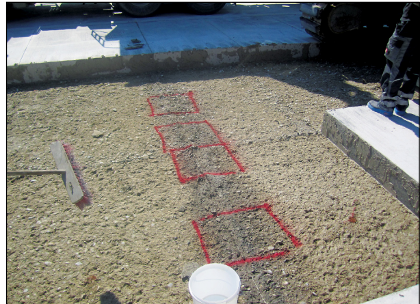
Bild 38: Oberfläche der modifizierten Kiestragschicht KTSuB im Fugenbereich, die Entnahmestellen sind rot markiert
