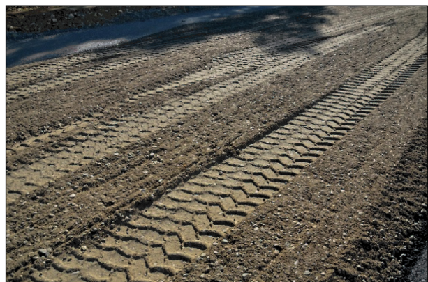
Bild 18: Oberfläche der modifizierten Kiestragschicht nach dem Gradereinbau und vor dem Verdichten
