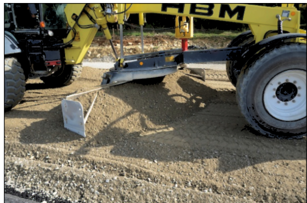
Bild 17: Einbau des modifizierten Baustoffgemisches mit einem Grader (Langmahdverfahren)
