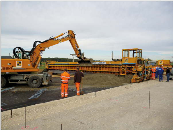
Bild 23: Herstellung der Lkw-Abstellfläche in Betonbauweise unmittelbar neben der Versuchstrecke; Anlieferung des Betons über die Kiestragschicht
