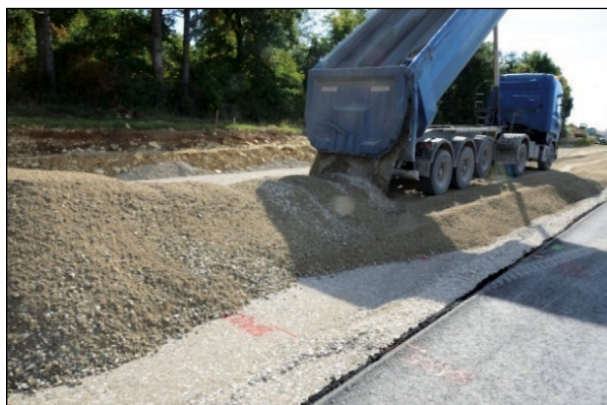
Bild 19: Abkippen des modifizierten Baustoffgemisches im Bau- feld
