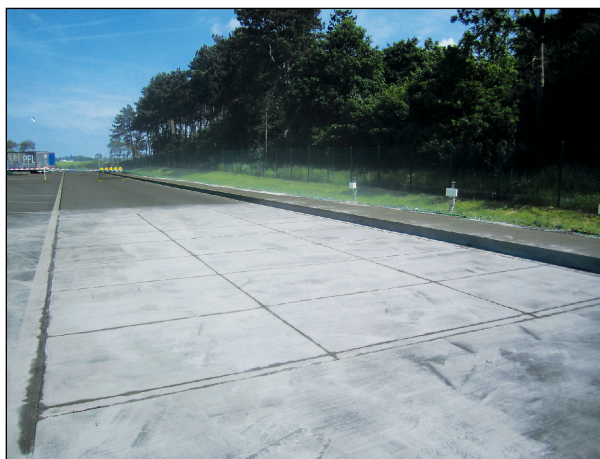
Bild 34: Segmentierte Einzelfahrbahnplatten der Versuchsstrecke
