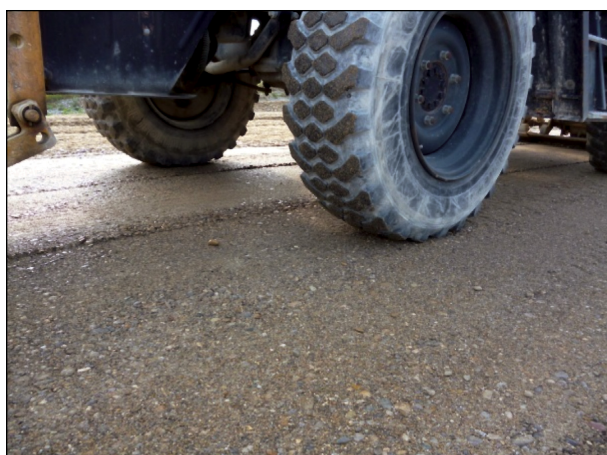
Bild 6: Hohe Standfestigkeit des eingebauten und verdichteten Baustoffgemisches
