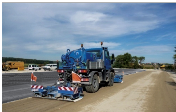
Bild 20: Verdichten mit Plattenverdichtern unter Wasserzugabe
