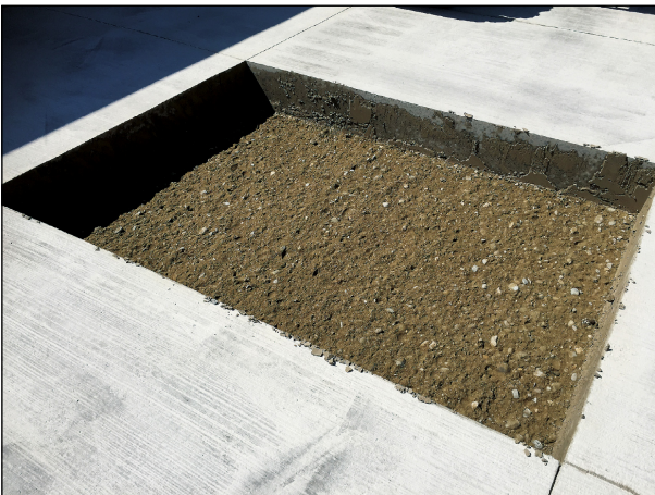
Bild 37: Oberfläche der modifizierten Kiestragschicht KTSuB nach dem Abheben des ersten Plattensegmentes
