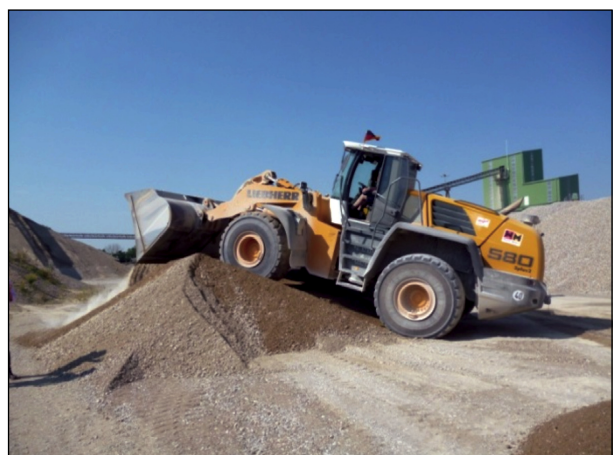
Bild 4: Dosierung und Mischung des Baustoffgemisches 0/32 mittels Radlader
