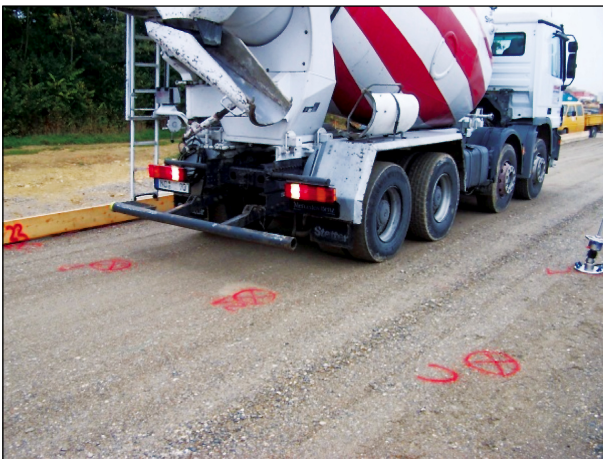
Bild 24: Baustellenverkehr im Bereich der Versuchstrecke; zu sehen sind auch die Prüfpunkte im Bereich der beiden wieder auszubauenden Einzelfahrbahnplatten
