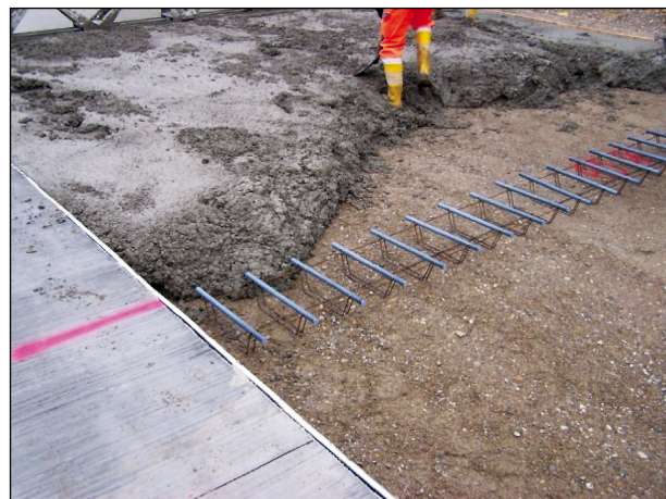
Bild 25: Herstellung der Betonfahrbahndecke im Handeinbau
