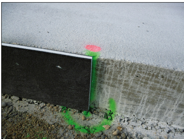
Bild 12: Angrenzende Lkw-Abstellfläche in Betonbauweise, Raumfugeneinlage
