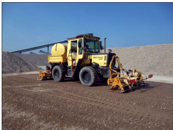
Bild 5: Einbau- und Verdichtungsversuche (Unimog mit Trenkplatten)
