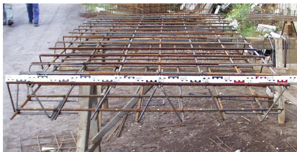
Bild 59. Herstellung des Bewehrungskorbes für den Chlorid-Probekörper.
