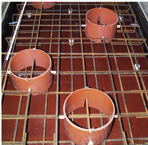
Bild 61. Eingeschalter Bewehrungskorb vor dem Betonieren, mit den Kunststoffrohren für die Präparation der Chloridnester.
