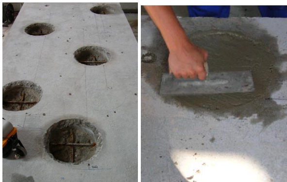
Bild 70. Der Chlorid-Probekörper der BAST nach dem Ausbohren der Chloridnester (links) und während der Neubetonierung.
