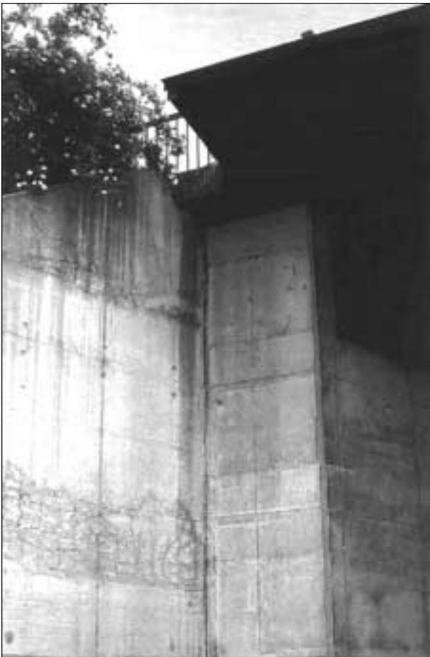
**Bild 2.9:** Widerlageransicht mit Laufspuren von rosthaltigem Wasser
