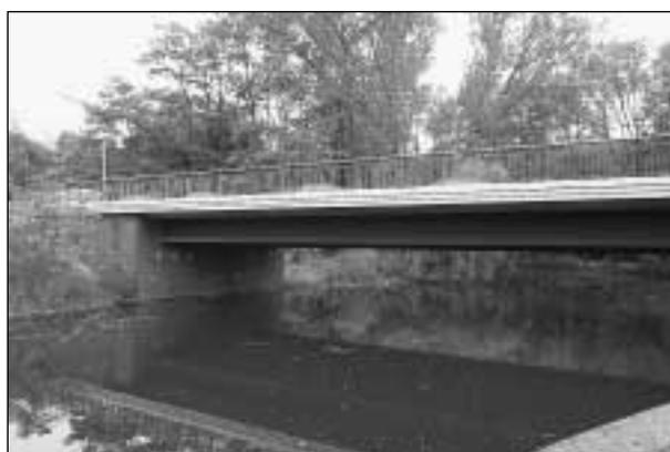
**Bild 2.15:** Ansicht Straßenbrücke über die Bille mit WT-Stahlträger
