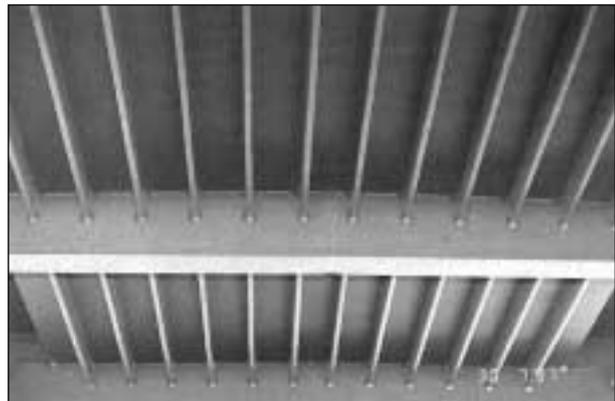
**Bild 2.2:** Untersicht einer Straßenbrücke mit Wulstflachstählen (Hollandprofile)
