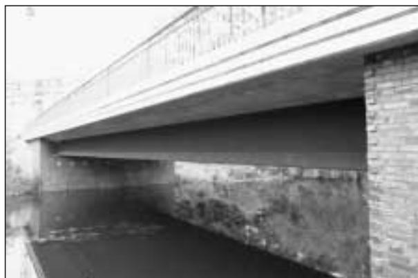
**Bild 2.16:** Ansicht WT-Stahlträger in Brückenlängsrichtung
