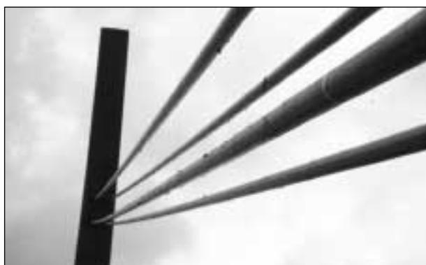
**Bild 3.12:** Ausgetretenes Seilverfüllmittel auf den Seilen der Brücke 10
