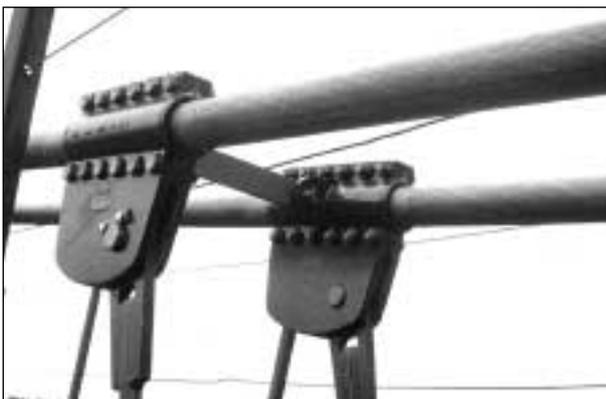
**Bild 3.21:** Schellen an Brücke 17
