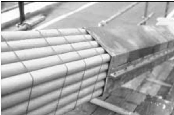
**Bild 3.17:** Kabel mit Schalung für den noch einzubringenden Injektionskörper
