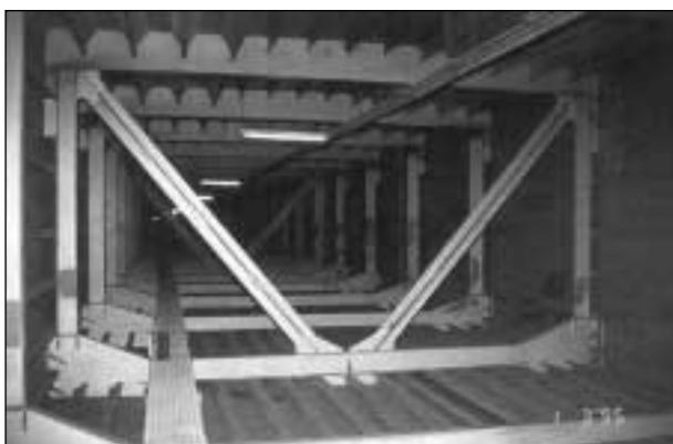
**Bild 1.22:** Inneres des Kastenquerschnitts mit Rissort oben links an Rahmen ohne Diagonalaussteifungen
