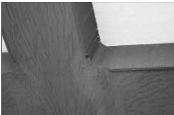
**Bild 2.23:** Wasserlaufspuren am Bodenblech der Kästen
