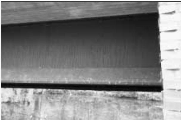
**Bild 2.18:** Stahlträger mit zwischen Steg und Untergurt angeschweißten Blechen
