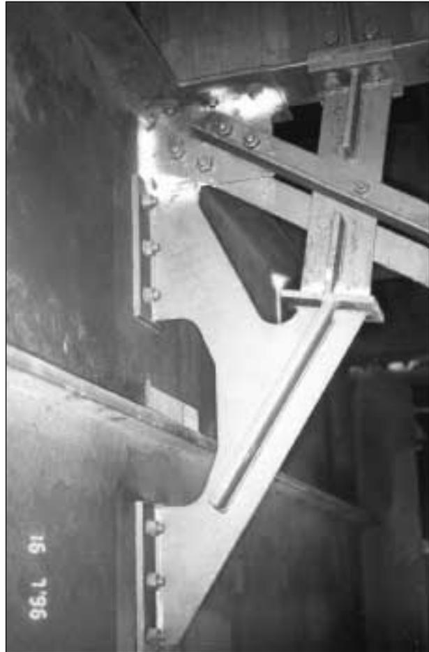
**Bild 1.15:** Verstärkung innen an Querschnitt mit Diagonale
