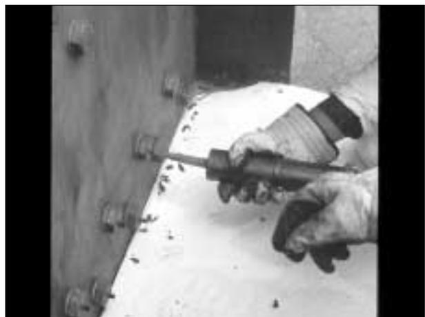
**Bild 1.28:** Einfüllung des Injektionsharzes
