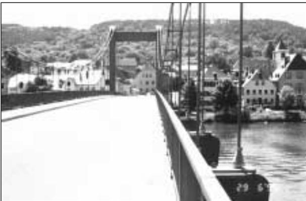
**Bild 3.20:** Hänger mit zwei Seilen an der Brücke 17
