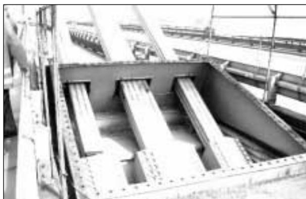
**Bild 3.26:** Spreizschellen Donaubrücke Deggenau
