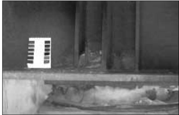
**Bild 2.10:** Ungünstige Lagerbereichsgestaltung mit Schmutzab-lagerungen
