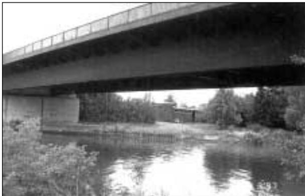
**Bild 2.4:** Straßenbrücke über den Mittellandkanal mit glatter Stegaußenfläche
