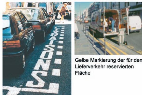
Eine Lieferzone in Parkstreifen integriert; Markierung in weiß
