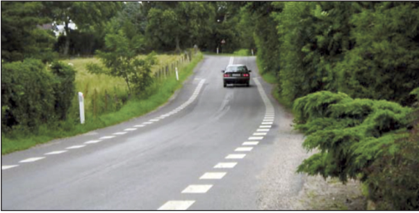
Bild 25: Übergangsbereich zwischen Markierungen als einstreifige und als zweistreifige Straße (HERRSTEDT, 2007)
