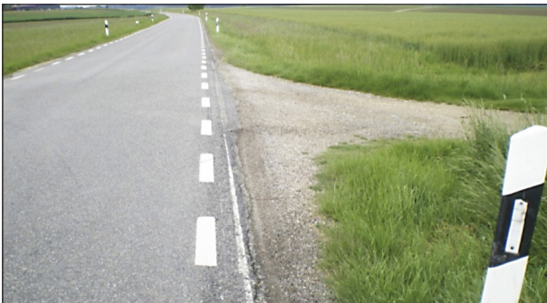
Bild 54: Gestaltung einer Feldzufahrt im Zuge der K 8239
