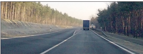
Bild 34: Beginn eines dreistreifigen Abschnitts der B 169 in Blickrichtung nach einem plangleichen KP mit LSA im Anschluss an eine Mittelinsel
