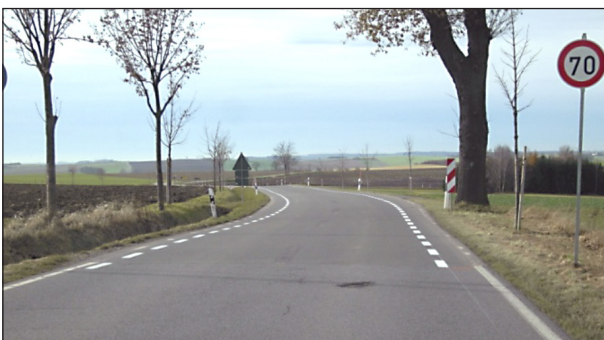
Bild 73: Übergangsbereich auf der K 7730 auf der freien Strecke (SCHLAG u. a., 2013)
