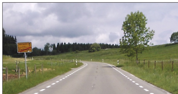
Bild 60: Phantommarkierungen (Leitlinie in der Fahrbahnmitte) auf der K 8240
