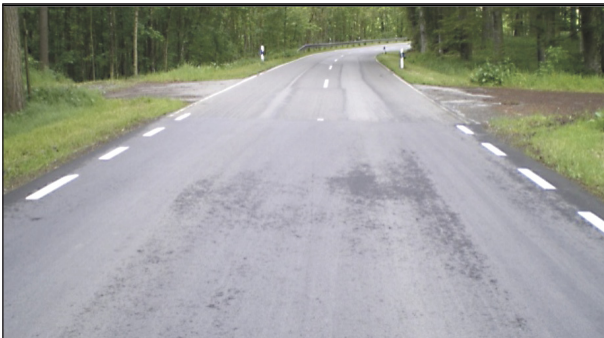
Bild 72: Übergangsbereich der K 8216 auf der freien Strecke
