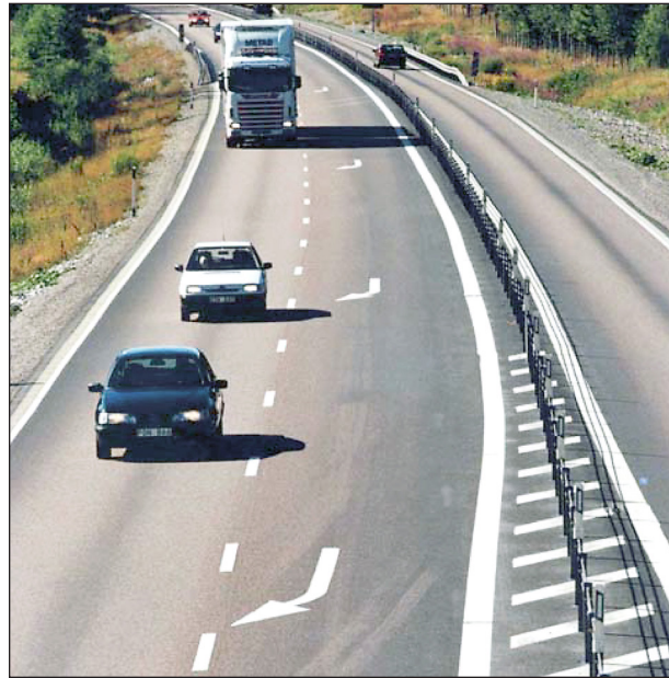
Bild 21: 2+1-Straße in Schweden (DERR, 2003)
