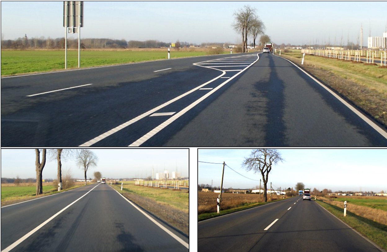
Bild 47: Übergang eines dreistreifigen Bereichs der B 101 auf der freien Strecke
