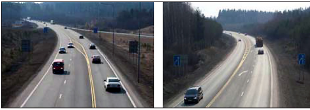
Bild 23: 2+1-Straße ohne bauliche Fahrtrichtungstrennung in Finnland (DERR, 2003)
