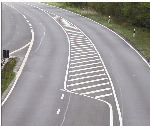
Bild 43: Übergang der B 3 am teilplangleichen Knotenpunkt
