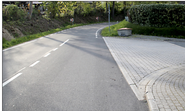
Bild 64: Übergang außerorts der K 18 am plangleichen Knotenpunkt
