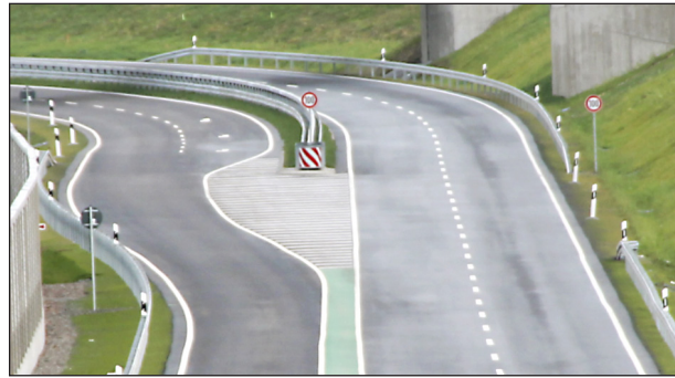
Bild 37: Übergangsbereich im Zuge der S 177
