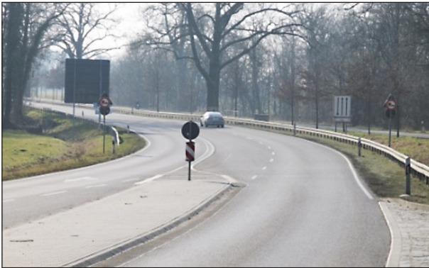
Bild 34: Beginn eines dreistreifigen Abschnitts der B 169 in Blickrichtung nach einem plangleichen KP mit LSA im Anschluss an eine Mittelinsel
