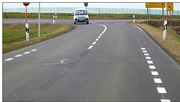
Bild 68: Übergangsbereich am KP K 7730/S 184 (SCHLAG u. a., 2013)
