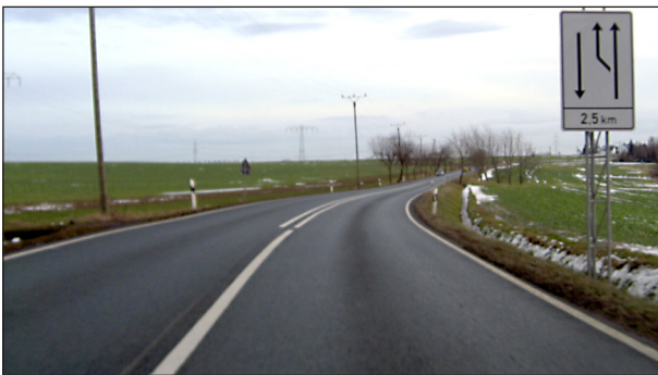
Bild 48: Übergang eines zweistreifigen Bereichs der B 169 zu einem zweistreifigen Bereich der bestehenden Straße auf der freien Strecke
