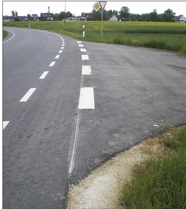
Bild 56: Markierung eines asphaltierten Wirtschaftsweges mit höherrangiger Bedeutung im Zuge der K 8217
