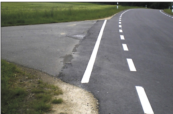
Bild 55: Markierung eines asphaltierten Wirtschaftsweges mit niederrangiger Bedeutung im Zuge der K 8217
