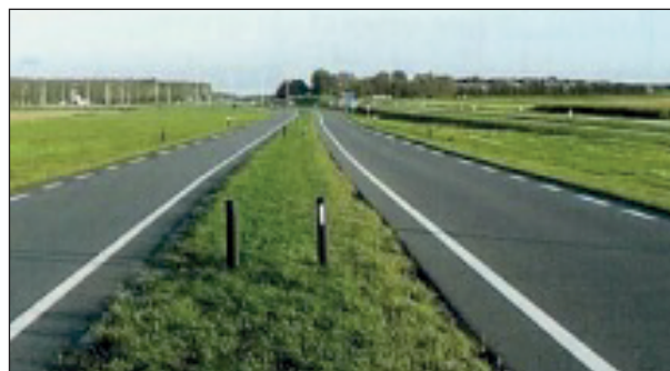
Bild 14: Flächenerschließende Straße mit baulicher Richtungstrennung (GOW I) (CROW, 2008)
