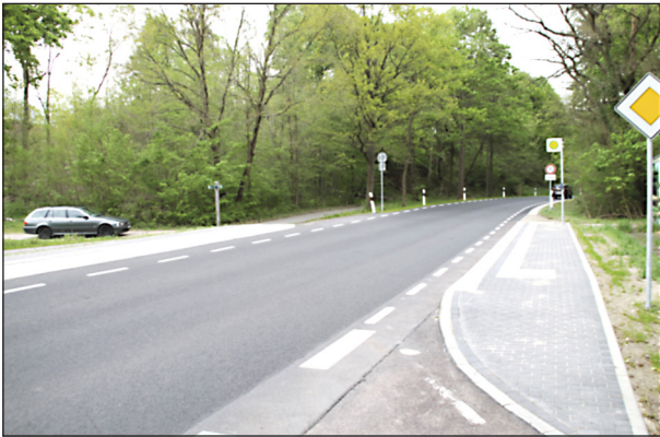
Bild 53: Bushaltestelle auf der K 6908 im Knotenpunktbereich
