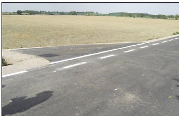
Bild 57: Befestigte Feldzufahrt der S 47
