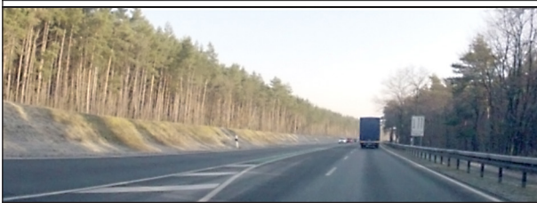
Bild 35: Übergang in Blickrichtung zwischen einem zweistreifigen Abschnitt des Bestands und einem dreistreifigen Abschnitt der EKL 1 auf der freien Strecke der B 169
