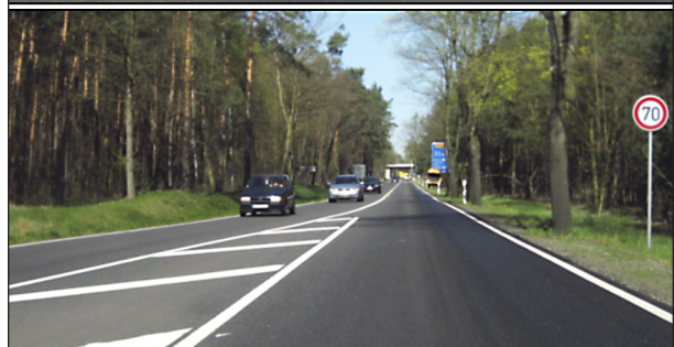
Bild 42: Übergang der L 48 am plangleichen Knotenpunkt ohne LSA
