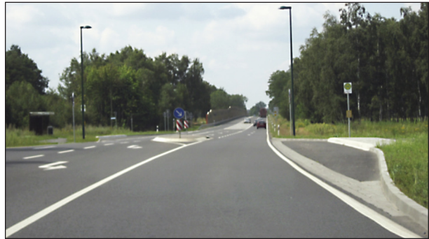
Bild 40: Bushaltestelle auf der B 87 im Knotenpunktbereich
