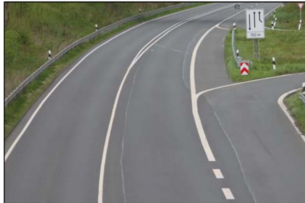
Bild 201: Übergang zum zweistreifigen Bereich innerhalb des KP 4
