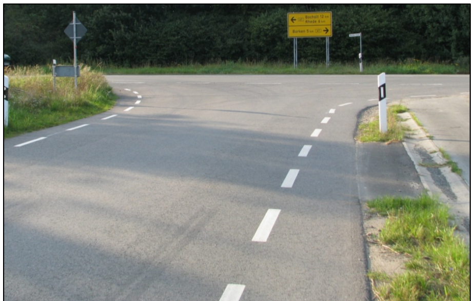
Bild 313: Übergangsbereich am Knotenpunkt mit der L 581, Blick von K 50 auf Knotenpunkt (SCHLAG U. A., 2013)
