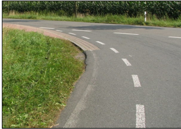
Bild 421: Übergangsbereich am Knotenpunkt mit der Hauptstraße, Blick von K 3 auf Knotenpunkt (SCHLAG U. A., 2013)
