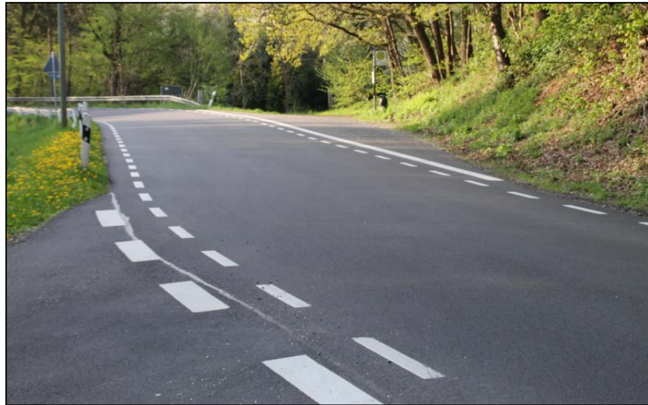
Bild 386: Markierung im Bereich der Zufahrt nach Bechhausen und im Bereich der Bushaltestelle
