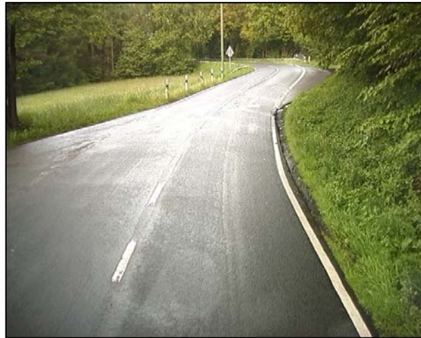
Bild 383: Markierung im Bestand im Bereich der Zufahrt und im Bereich der Bushaltestelle (RHEINISCH BERGISCHER KREIS)
