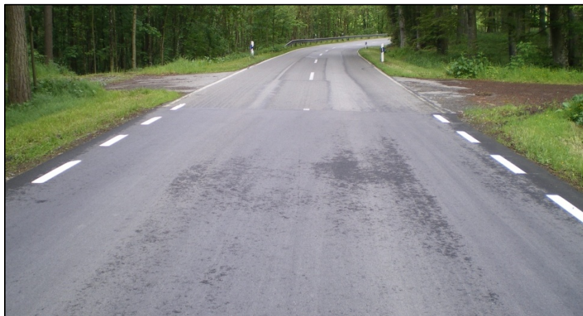
Bild 365: Übergangsbereich am Ende der Deckensanierung auf freier Strecke
