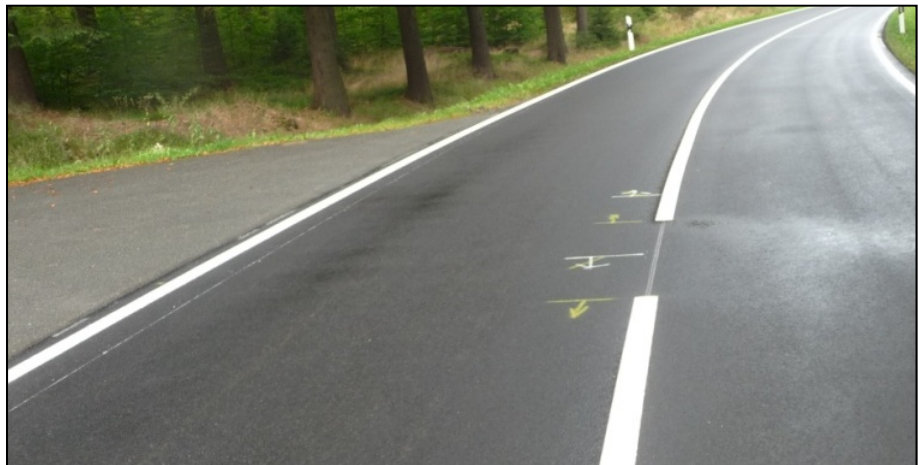
Bild 289: Unterbrechung der Fahrstreifenbegrenzungslinie durch eine 2 m breite Lücke
