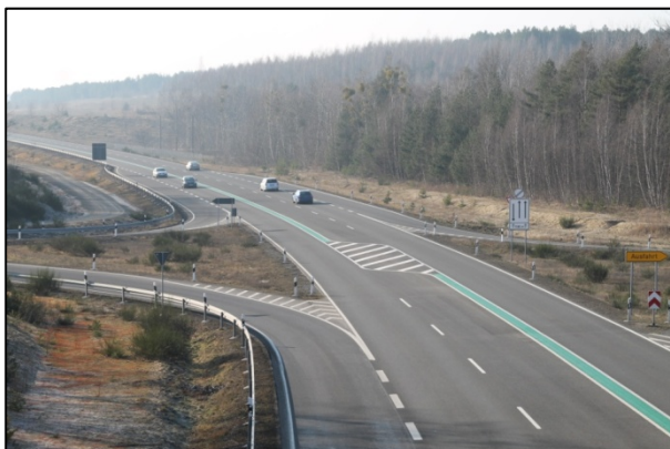
Bild 93: Netzknoten 4449035, Blick Richtung Norden auf B 169 und überführte L 60
