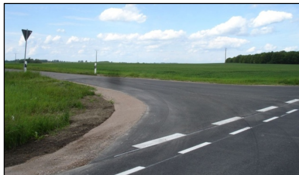
Bild 372: KP mit Pyrnaer Straße
