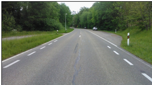
Bild 335: Beginn Übergangsbereich vor Sigmaringendorf
