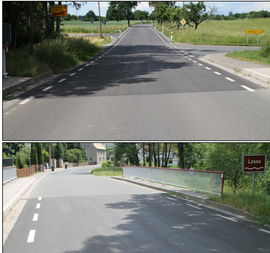
Bild 401: Übergangsbereich der S 20 an der Ortstafel von Kleinzschepa
