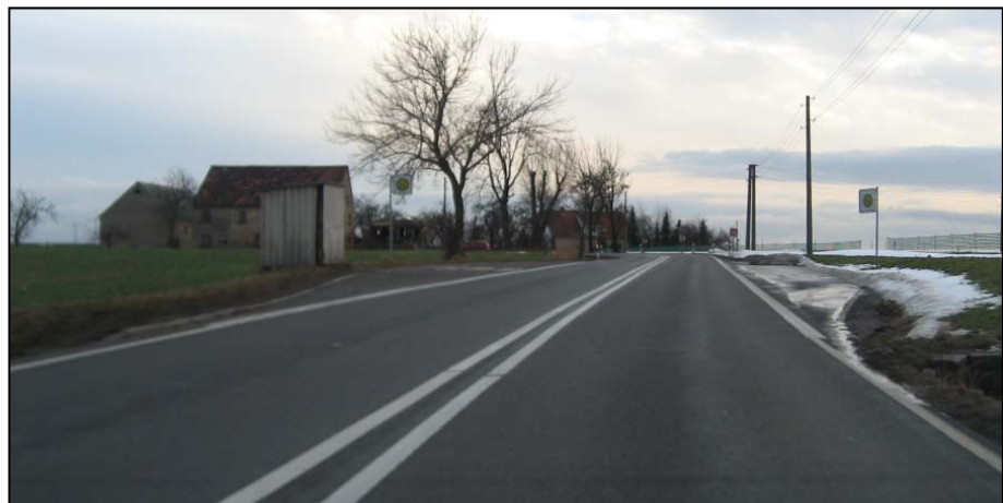
Bild 249: Bushaltestelle im Zuge der B 169
