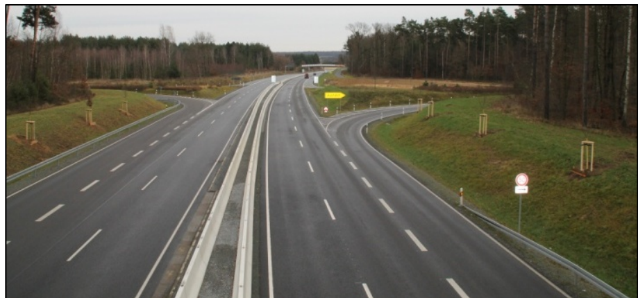
Bild 130: NK 5049 040, Blick Richtung Norden von S 167 auf S 177
