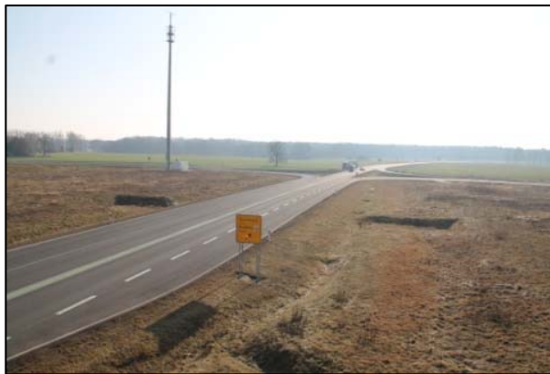
Bild 84: Netznoten 4351030, Blick Richtung Süden von L 52 auf B 169
