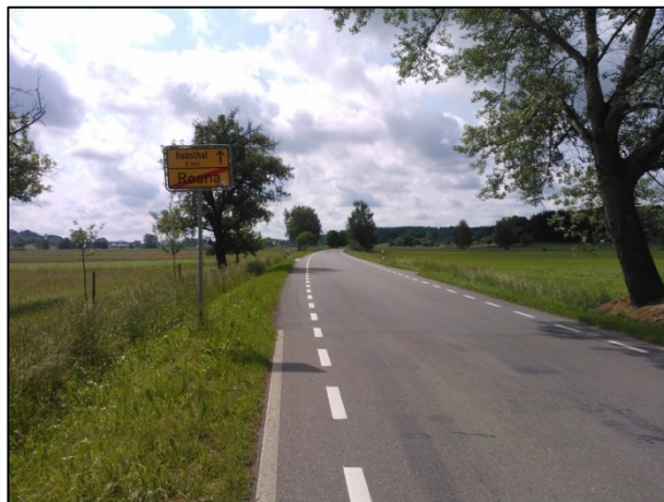
Bild 343: Beginn Übergangsbereich OA Rosna
