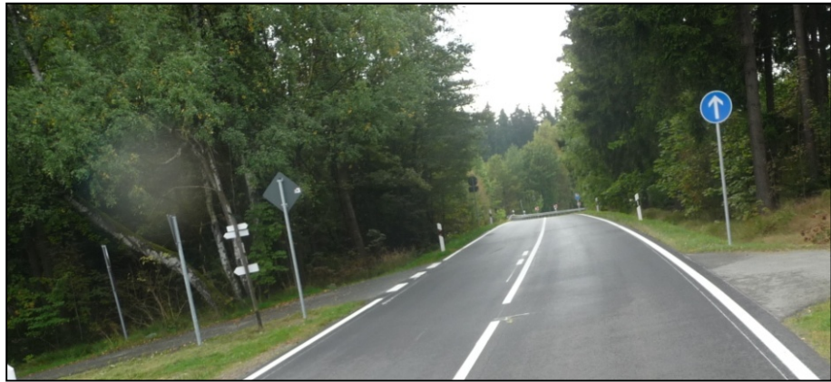
Bild 290: Einmündung im Zuge der S 302
