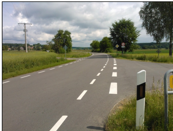
Bild 341: Markierung des Abzweigs nach Eimühle
