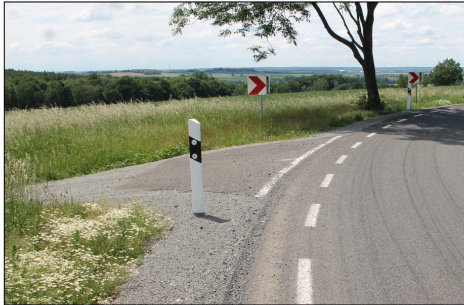
Bild 398: Zufahrt eines Wirtschaftsweges mit Markierung
