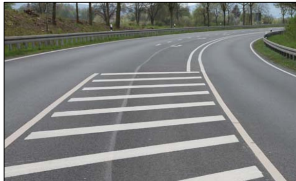
Bild 202: Übergangsbereich am KP 5
