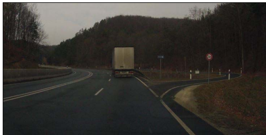
Bild 270: Einmündung am KP 3
