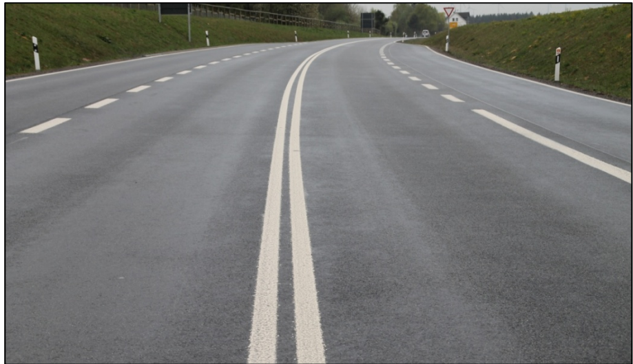
Bild 179: Übergangsbereich vor KP 1, Blickrichtung Süden
