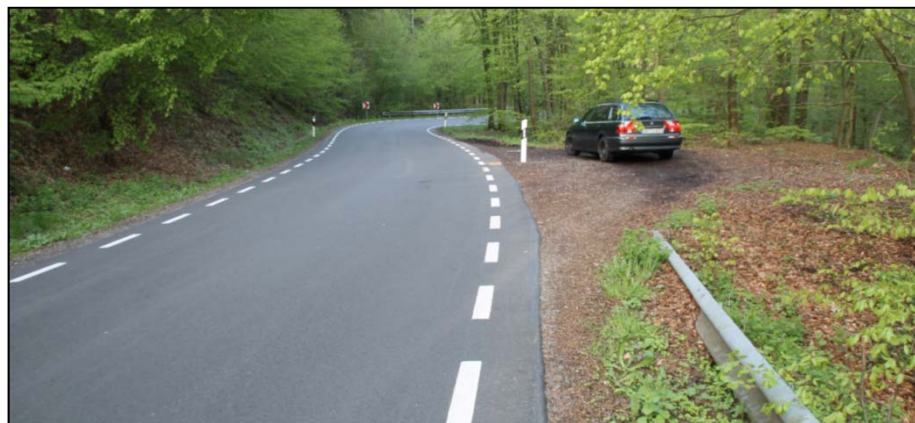
Bild 387: Markierung von Ausweichstellen
