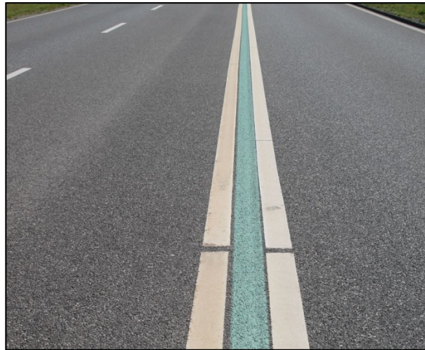
Bild 140: Grünarkierung zwischen bestehenden Fahrstreifenbegrenzungslinien
