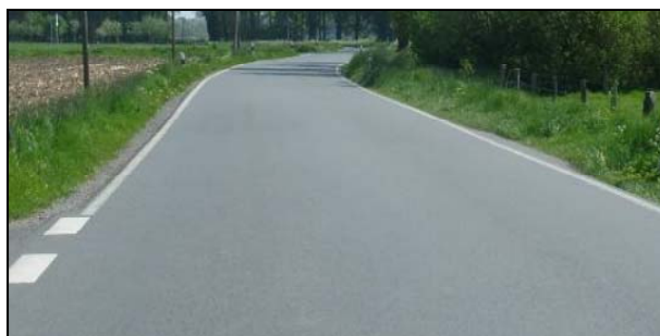
Bild 416: Markierung im Bestand (LANDESBETRIEB STRAßENBAU NRW)
