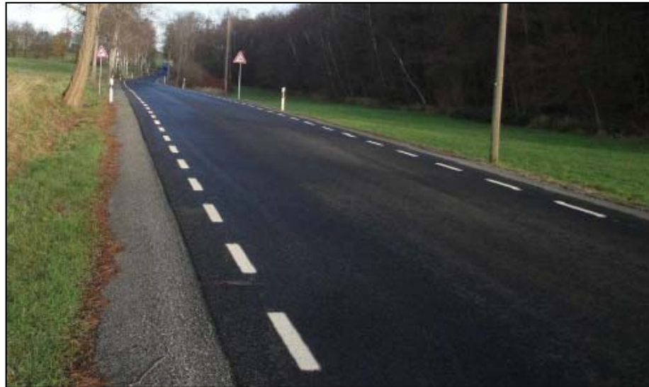
Bild 392: Markierung der S 20 auf der freien Strecke (LASuV Leipzig)
