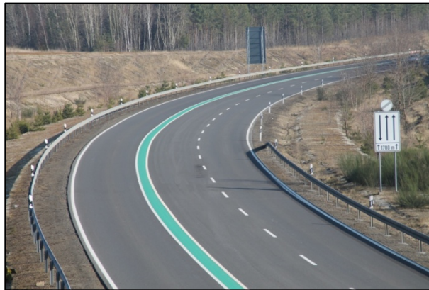
Bild 90: Markierung der B 169 im dreistreifigen Bereich
