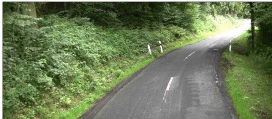
Bild 380: Fahrbahn im Bestand mit Mittelmarkierung (Landesbetrieb Straßenbau NRW)
