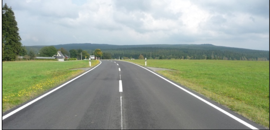
Bild 288: Mittelstreifenmarkierung in unkritischen Bereichen
