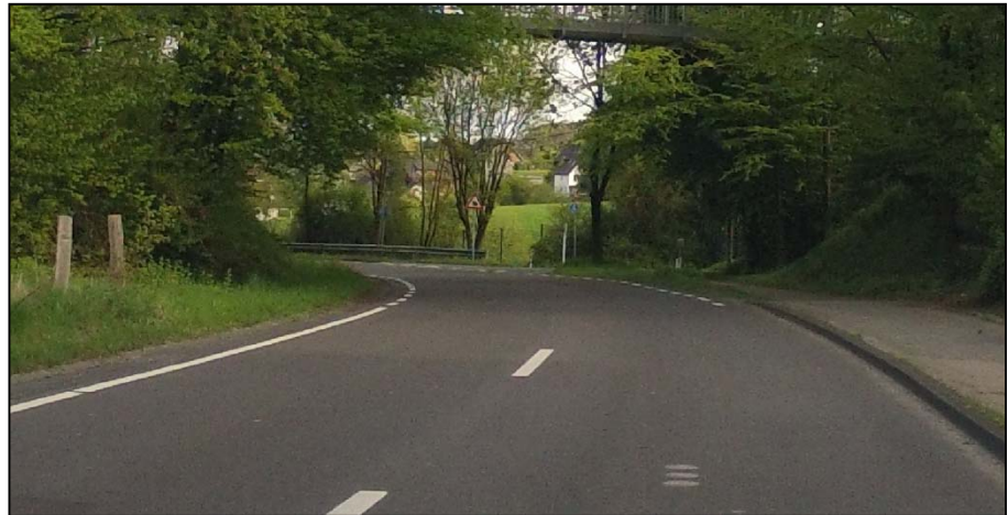
Bild 388: Übergangsbereich aus Hilgen
