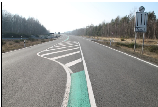
Bild 91: Netzknoten 4449038, Blick Richtung Süden auf unkritischen Wechsel
