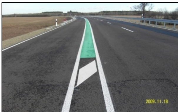
Bild 81: Umsetzung (LANDESBETRIEB STRAßENWESEN BRANDENBURG)
