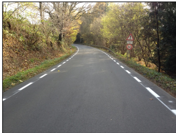
Bild 384: Markierung freie Strecke
