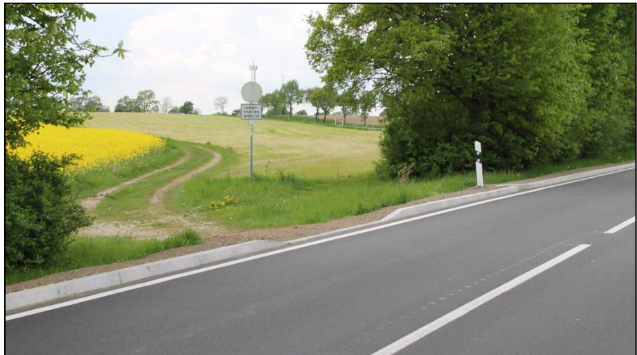
Bild 300: Feldwegzufahrt mit abgesenktem Bordstein
