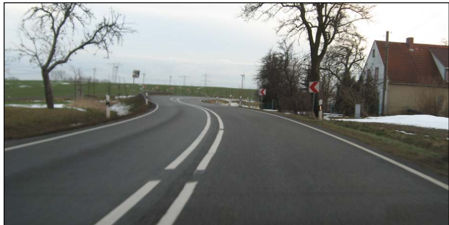
Bild 248: Grundstückszufahrt im Zuge der B 169
