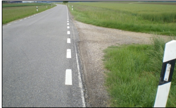
Bild 349: Markierung der Feldwege ohne Schmalstrich
