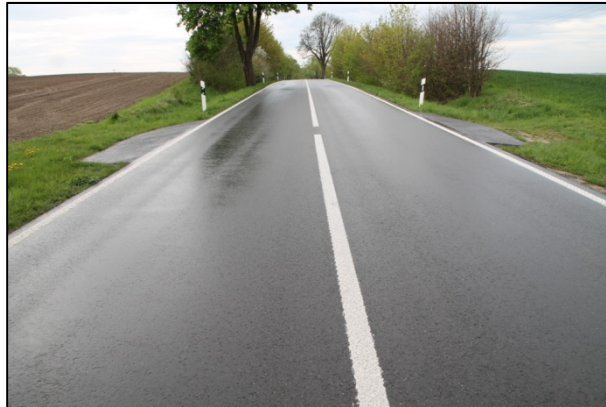
Bild 306: Markierung nach der Deckenerneuerung
