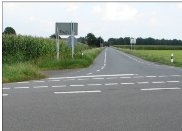
Bild 422: Übergangsbereich am Knotenpunkt mit der K 4, Blick von Knotenpunkt Richtung Osten auf die K 3 (SCHLAG U. A., 2013)
