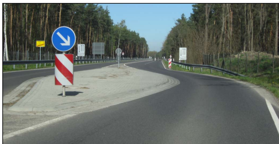
Bild 213: Übergangsbereich von innerorts nach außerorts an der Ortstafel Gablenz (LIPPOLD U. A., 2011)
