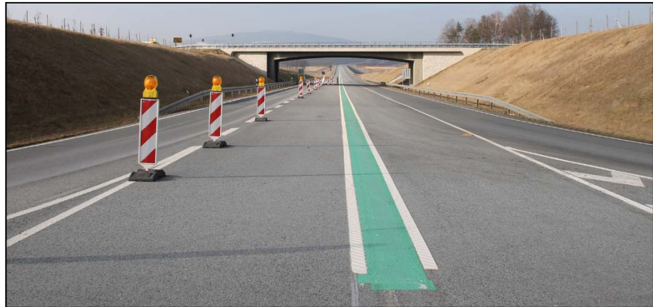
Bild 110: Verkehrsführung am Knotenpunkt bei Niederoderwitz, Blick in Richtung Löbau
