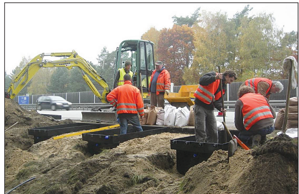
Bild 6: Einbau der Lysimeterwannen
