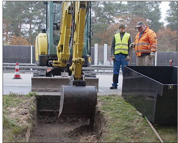
Bild 4: Ausheben der Lysimetergruben
