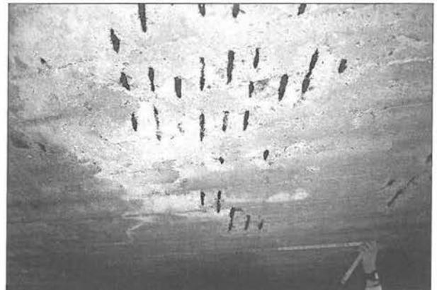
Bild 4: Chloridkorrosion an der Unterseite einer Fahrbahnplatte
