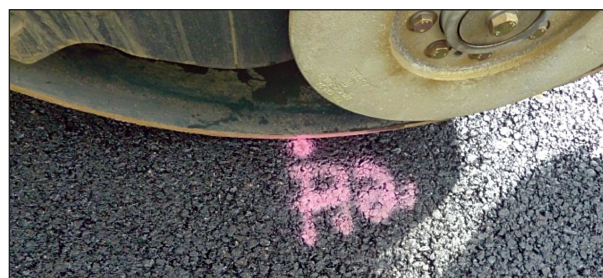
Bild 3.1: Markierung der rechten Bandage während des Einbaus
