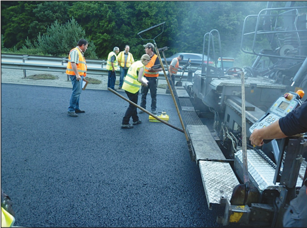
Bild 3.13: Messung der Vorverdichtung durch den Fertiger mittels Troxlersonde
