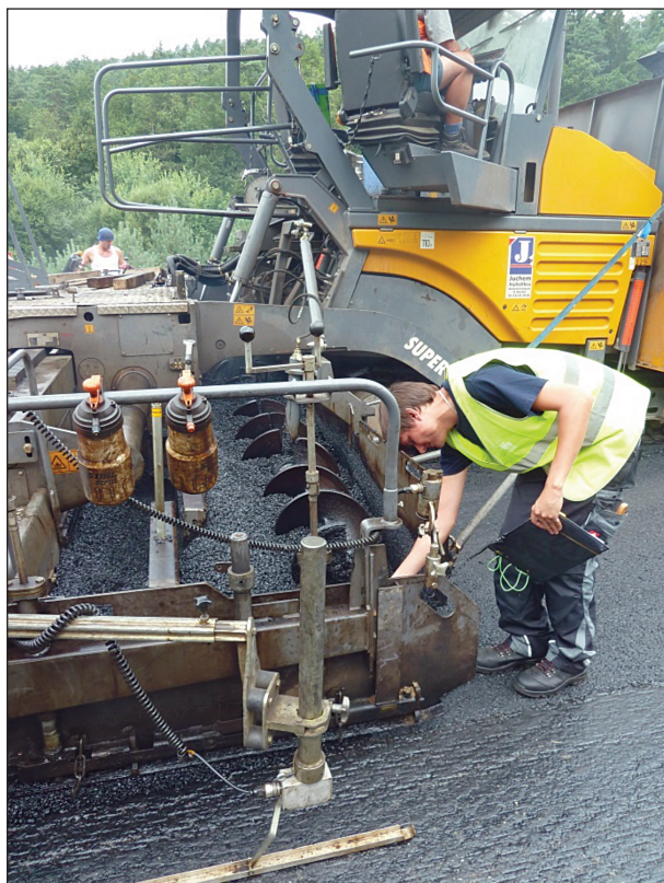
Bild 3.5: Messung der Temperatur an der Verteilerschnecke
