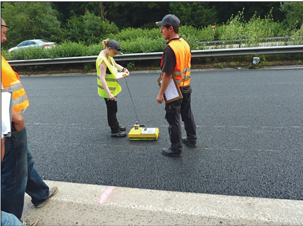
Bild 3.8: Messungen der Temperatur während der Dichtemessungen mit der Troxlersonde
