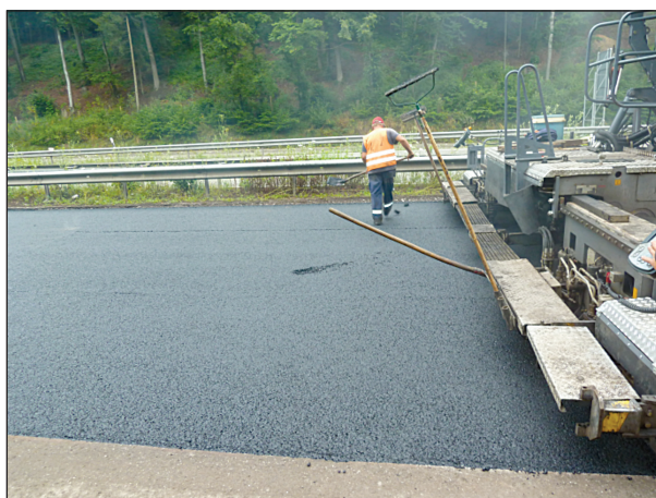
Bild 4.3: Schlackeentnahme auf der Bundesstraße B 10
