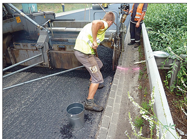
Bild 3.11: Mischgutentnahme auf der Bundesstraße B 10 an der Verteilerschnecke des Fertigers
