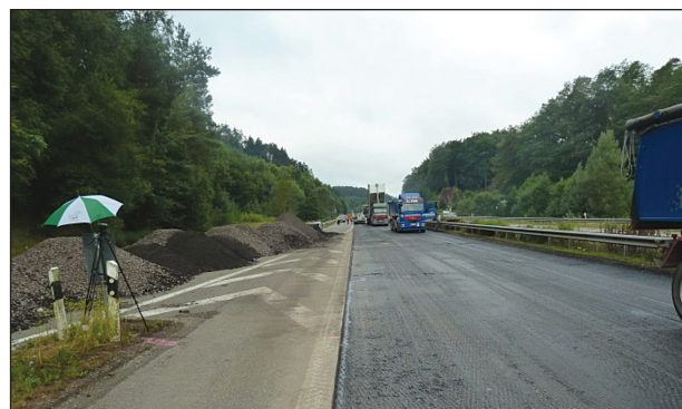
Bild 3.16: Position der Kamera zur Dokumentation des Bauablaufs und der Walzübergänge
