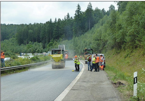
Bild 3.14: Messung der Dichte mit der Troxlersonde während des Einbaus
