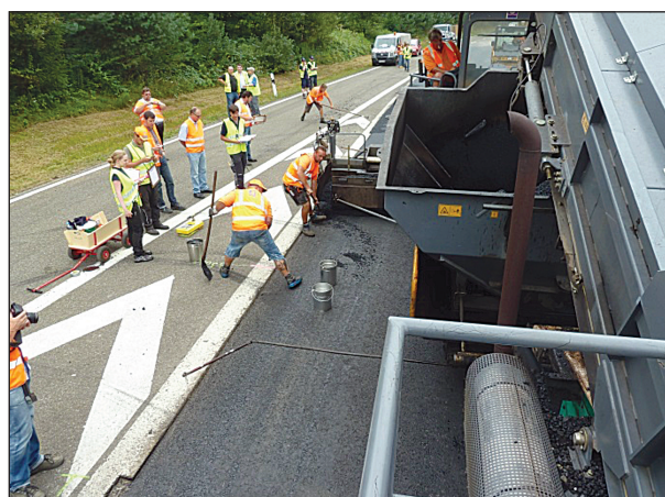
Bild 3.12: Mischgutentnahme auf der Bundesstraße B 10 an der Verteilerschnecke des Fertigers
