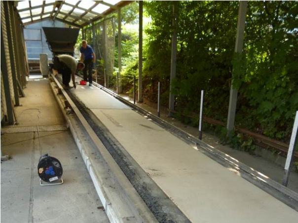
Bild 7: Aufbringen der Holzunterlage auf einer bestehenden Asphalt-schicht
