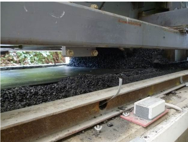
Bild 9: Einbau des Mischguts PA 8 mittels Spezialfertiger
