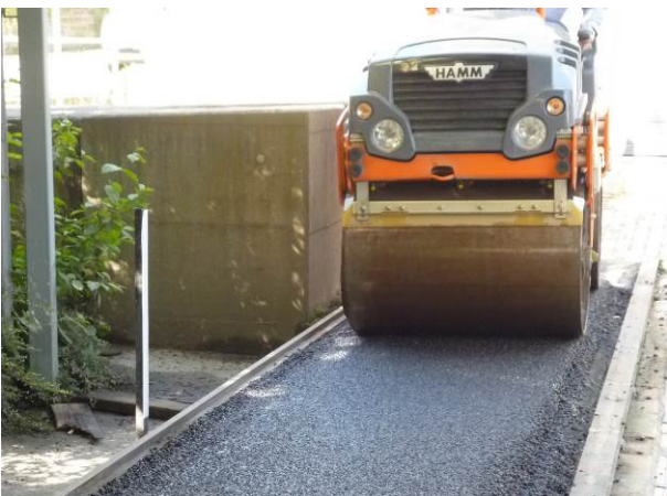
Bild 11: Abschließende Walzverdichtung (statisch)
