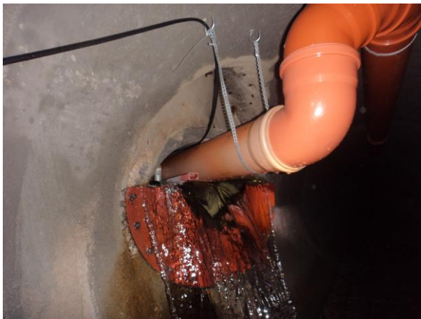
Abbildung 2: Überströmtes Messwehr an der Westulmendrainage
