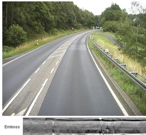
**Bild 96:** Beispiel für einen Abschnitt mit einem SPT von 6 mm und einem MAX\_SPT\_MW\_20 von 12 mm, Bundesstraßen Land A
