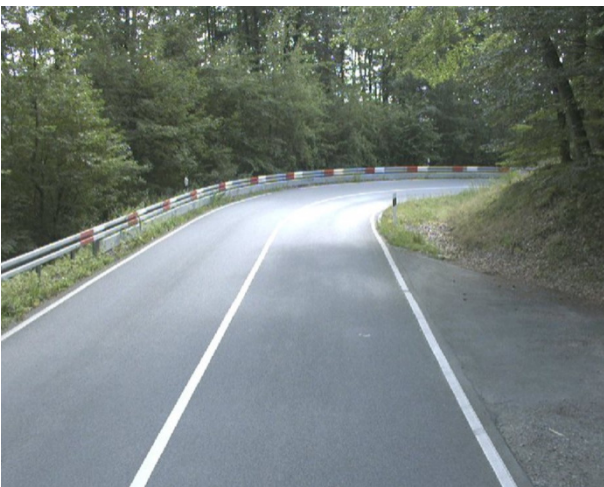
Bild 141: Beispiel für einen Abschnitt mit einem Kurvigkeitsäquivalent von 180 gon/100 m
