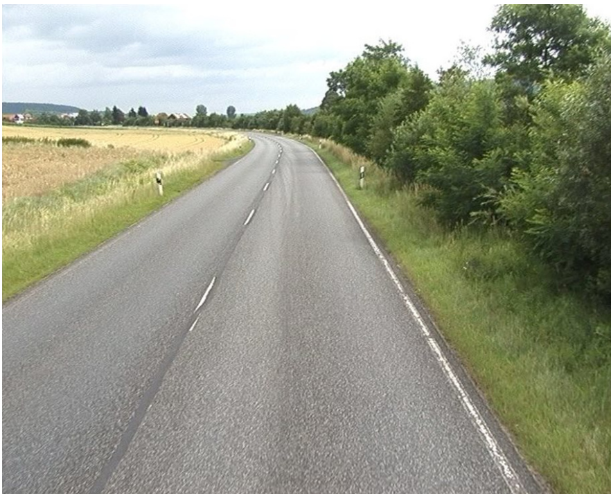
Bild 189: Beispiel für einen Abschnitt mit einem SPH von 2,4 mm und einem MAX_SPH_MW_20 von 4 mm, Bundesstraßen Land A
