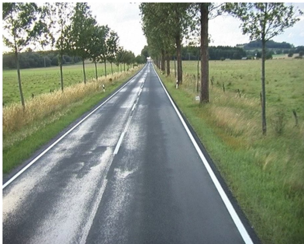
Bild 168: Beispiel für einen Abschnitt mit einem Delta von 0,250 zwischen GRI_60 und MIN_GRI_MW_20, Bundesstraßen Land A
