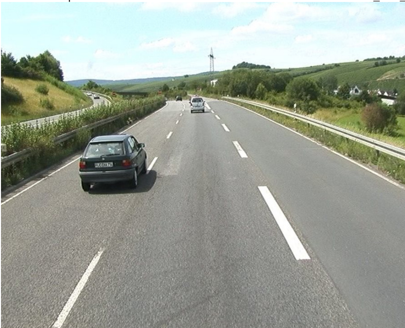
Bild 182: Beispiel für einen Abschnitt mit einem SPT von 6 mm und einem MAX_SPT_MW_20 von 12 mm, Bundesstraßen Land A
