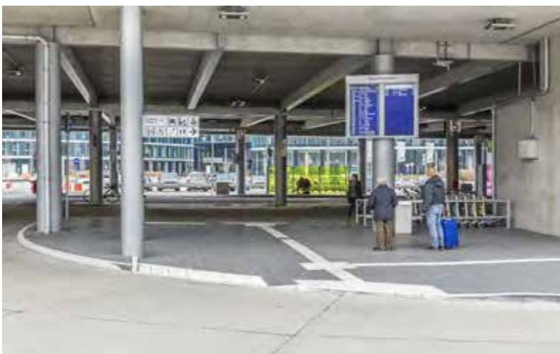
Bild 52: Überquerungsstelle mit differenzierter Bordhöhe – Stuttgart
