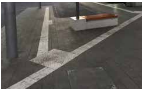
Bild 47 Bodenindikator-basiertes Leitsystem (Abzweig zur Haltestelle) – Hannover
