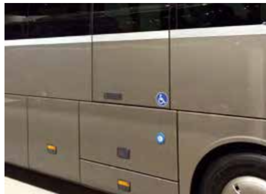
Bild 4: Kennzeichnung der Betriebstür (hier: Schlagtür) für den Zugang eines Rollstuhlfahrers mittels Piktogramm
