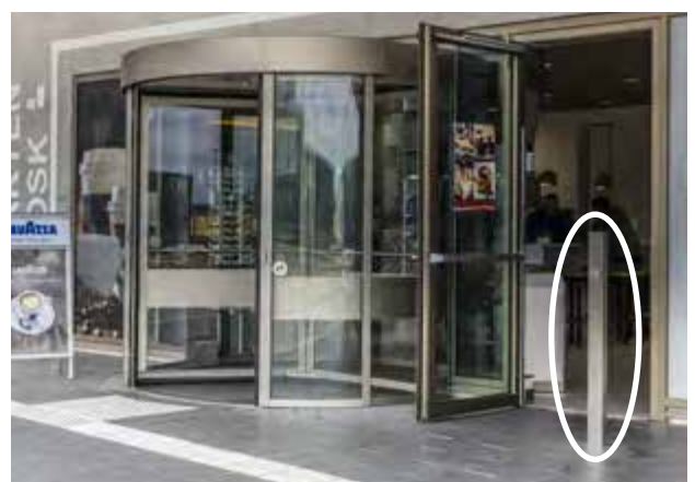
Bild 58: Zugang zu einem Wartebereich mit separater Tür für Rollstuhlfahrer (rechts) und Anforderungstaster – Stuttgart
