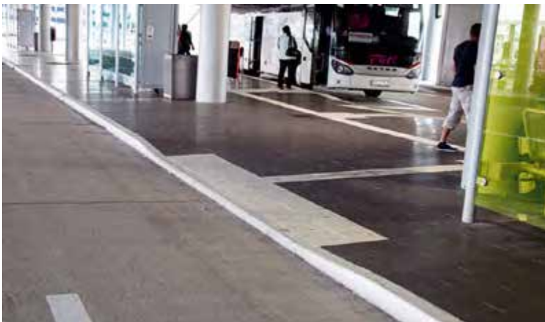
Bild 50: Überquerungsstelle mit einheitlicher Bordhöhe – Stuttgart
