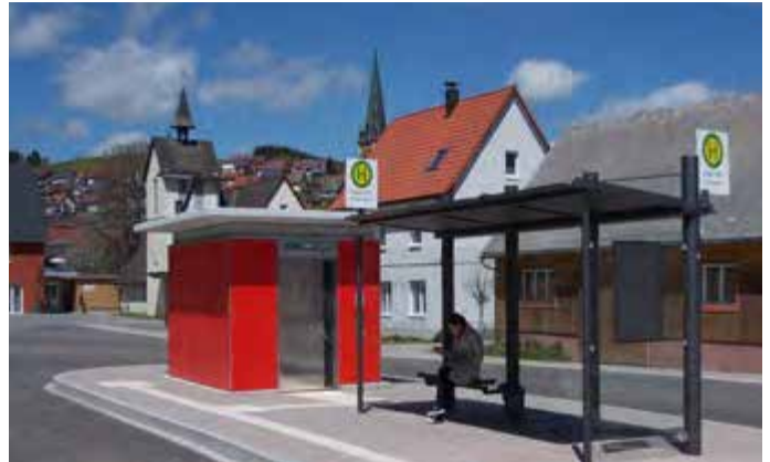
Bild 62: Bewirtschaftetes Toilettenhäuschen (rollstuhlgeeignet) an einem Busbahnhof
