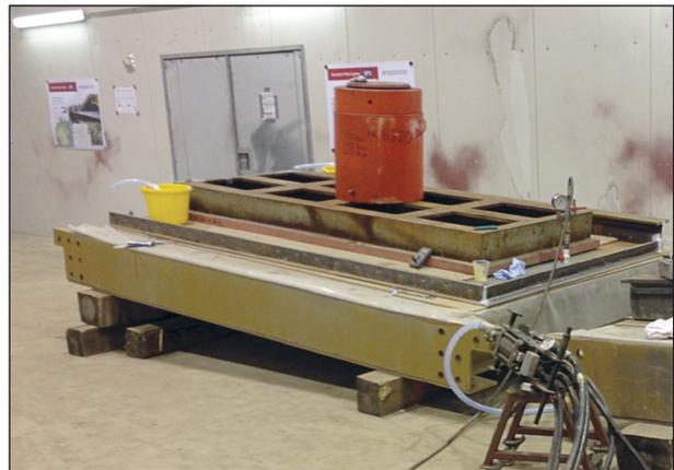
**Bild 39:** Herstellung der SPS-Paneele für die Saarbrücke Mettlach im Werk
