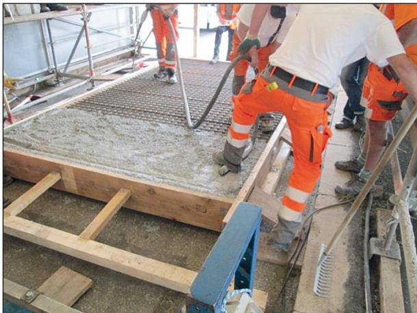
**Bild 16:** Verdichtung der ersten Probeplatte mit Rüttelflaschen
