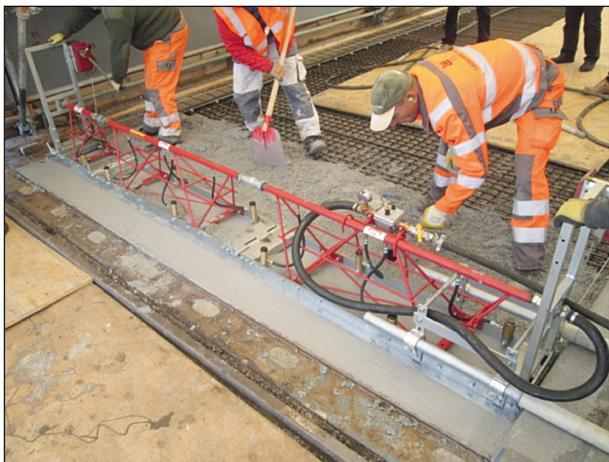
Bild 23: Verdichtung mit Rüttelbohle (druckluftbetrieben)
