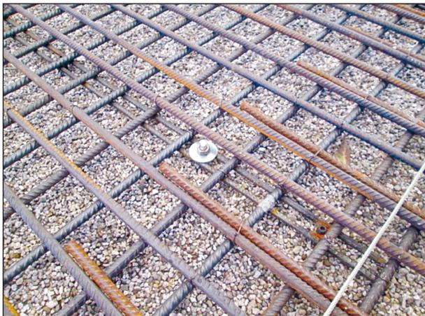
**Bild 18:** Bewehrung der Fahrbahnplatte mit Niederhalter
