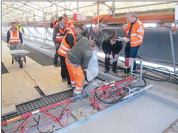
Bild 22: Einbau des Betons
