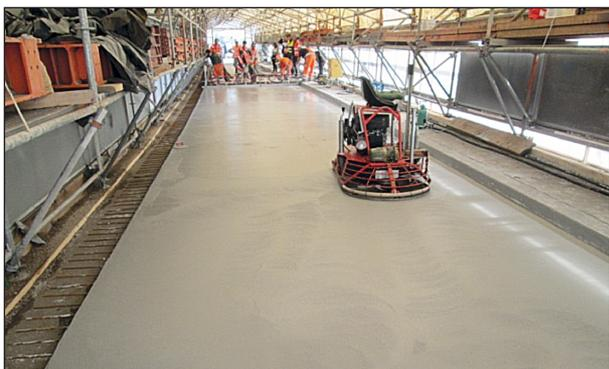
Bild 24: Glätten der Betonoberfläche
