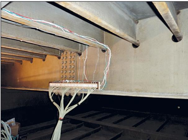
Bild 14: Kabelbündelung im Hohlkasten
