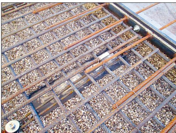
**Bild 19:** DMS an der Bauabschnittsfuge in Längsrichtung
