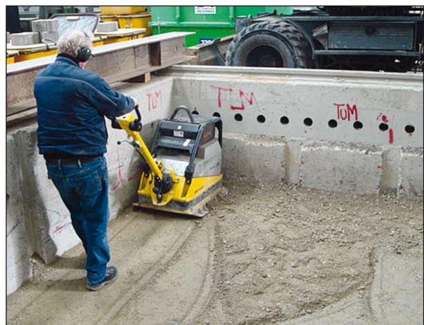
Bild 45: Verdichtung der Frostschutzschicht in der Versuchsgrube
