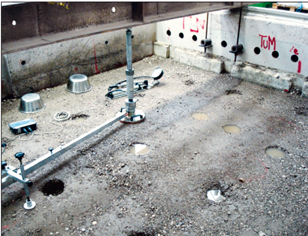
Bild 60: Durchführung eines statischen Plattendruckversuchs nach Bewässerung des Bodens
