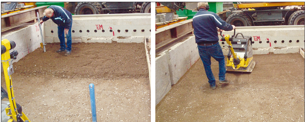
Bild 47: Verdichtung der zweiten Versuchsmischung
