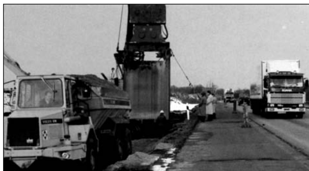
Bild 4.29: Bodenaustausch zur Verbreiterung der BAB A 27 (MÖBIUS, 1999)
