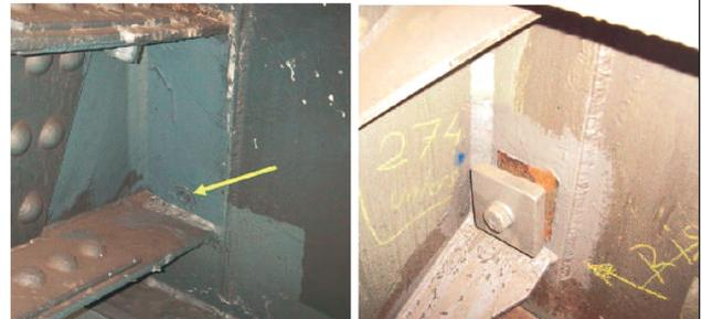
Bild 29: Instandsetzungsvorschlag des unteren Anschlusses der Schrägstreben, aus [U35]
