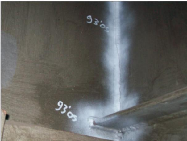
**Bild 46:** Schweißnaht im Anschluss Querträger an den Hauptträger-Steg, aus [U57]
