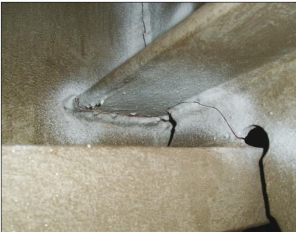
**Bild 47:** Riss unterhalb des Querträger-Untergurts, aus [U57]
