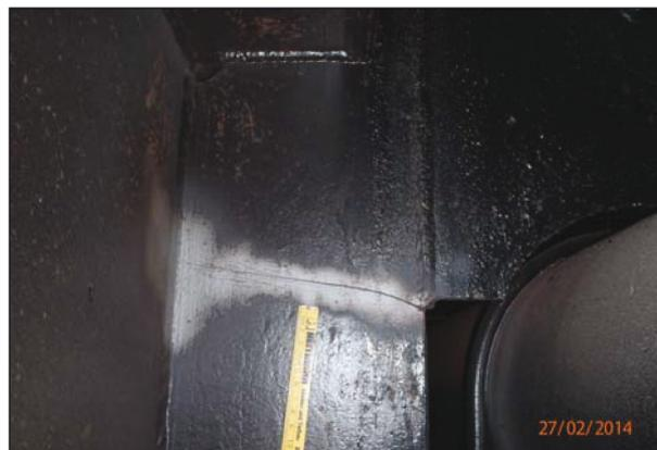
**Bild 54:** Riss in der Quersteife ausgehend von dem Umschweißung des Knotenblechs, aus [U59]
