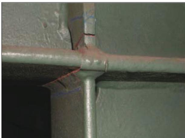
**Bild 15:** Risse im Bereich des geschweißten Anschlusses zwischen dem Gurt der HT-Quersteife und dem QT-Untergurt, aus [U23]
