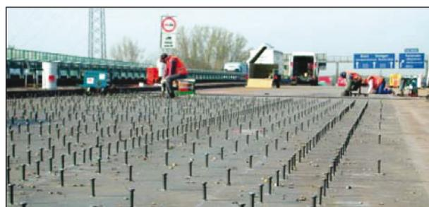
**Bild 18:** Aufschweißen von Kopfbolzendübeln zur Erzielung einer Verbundwirkung, aus [U23]
