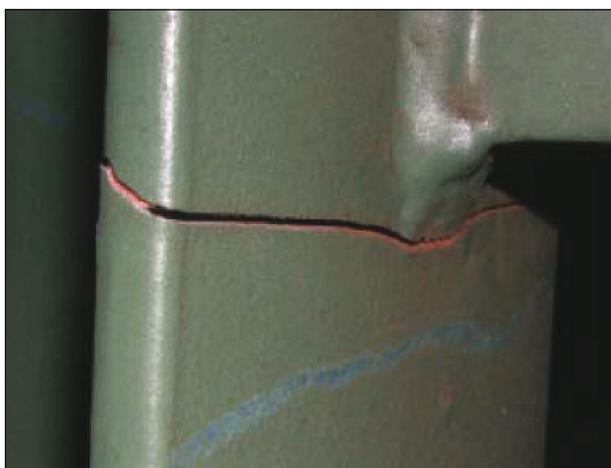
**Bild 16:** Riss im Gurt der HT-Quersteife unterhalb der Umschweißung des FW-Knotenblechs, aus [U23]
