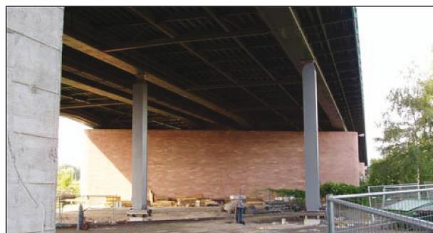
**Bild 17:** Zusätzliche Stahlstützen zur Halbierung der Spannweite in den Randfeldern, aus [U21]
