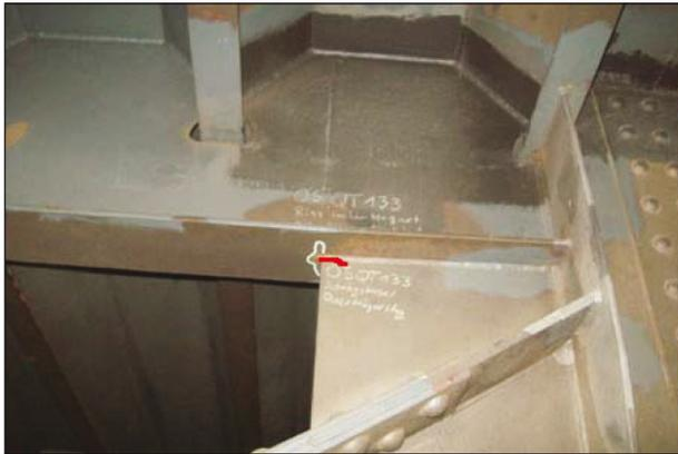
**Bild 43:** Risse im Bereich des oberen Strebenanschlusses an den Querträger, [U56]
