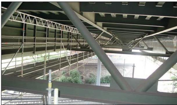
**Bild 13:** Autobahnbrücke bei Durlach (A 5) Untersicht mit Querträger, Längsträger und Querfachwerk [U21]
