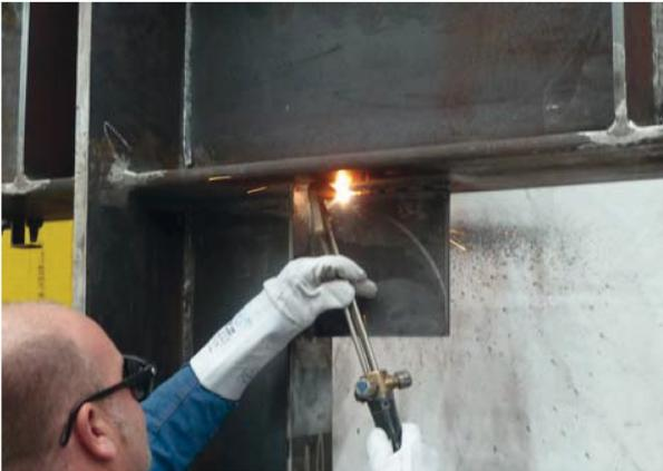
Bild A 23: Umbau Versuchskörper 01 – Herauslösen des alten Knotenblech durch autogenes Brennschneiden
