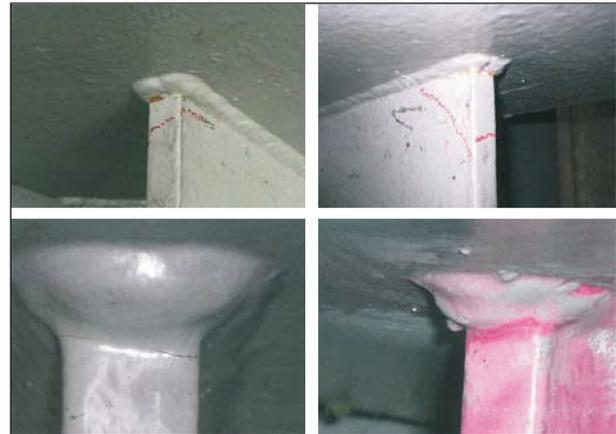
**Bild 21:** Bei der HP 2010 festgestellte Schweißnahtisse an der Umschweißung der Auflagersteifen zum Untergurt des EQT, aus [U25]
