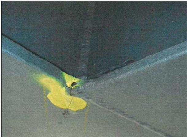
**Bild 38:** Riss im Hauptträger-Untergurt ausgehend von der Schweißnaht mit dem Querträger-Untergurt, aus [U51]
