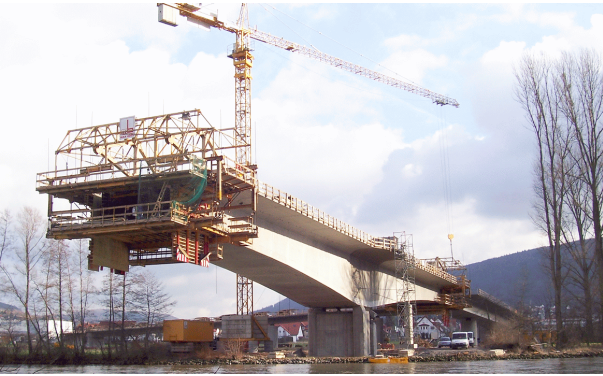
Bild 3: Freivorbau BW 11; Quelle: BÜCHTING+STREIT AG
