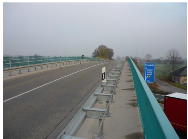
Bild 3: Überführungsbauwerk B426 „alt“/BAB A 67 (Quelle: LCEE GmbH)
