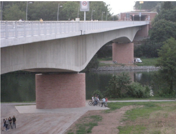
Bild 4: Blick auf fertiggestelltes BW11; Quelle: Buech-ting+Streit AG
