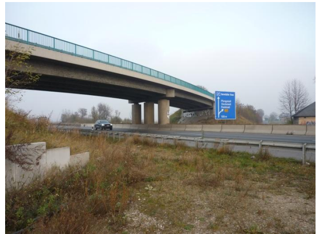
Bild 1: Überführungsbauwerk B426 „alt“/BAB A 67 (Quelle: LCEE GmbH)
