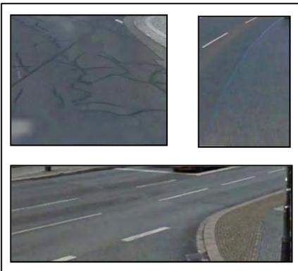
Griffigkeitsprobleme (v.a. Längsbitumenvergüsse) und Unebenheiten (v.a. Spurrillen)
