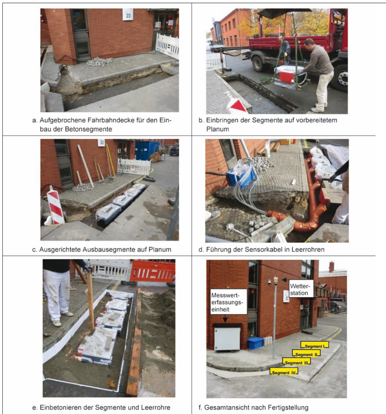
Bild 86: Erstellung des Monitoringsystems
