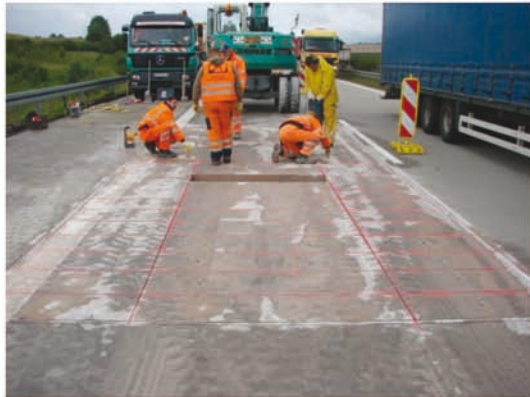
a. Einbringen der Lastaufnahmeösen in Betonfahrbahndecke
