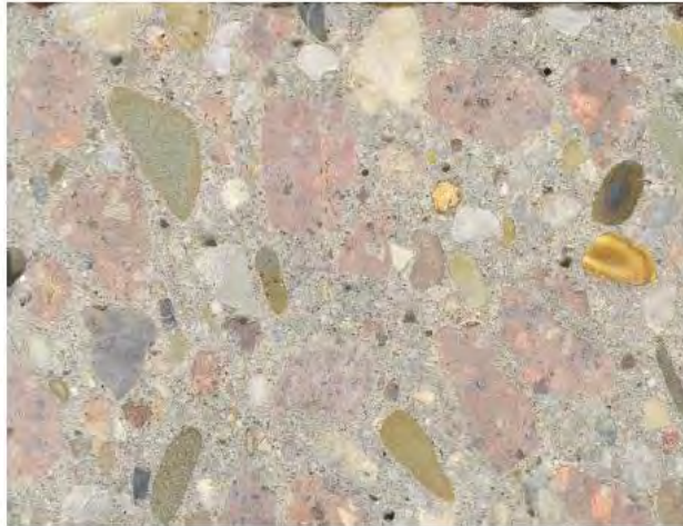
Abbildung 4. Bild der Straßenbetonoberfläche einer Probe. Die unterschiedlich großen und verschiedenen Zuschläge lassen ein Bohren der Hohlräume für die Aufnahme der Sensoren nicht zu.
