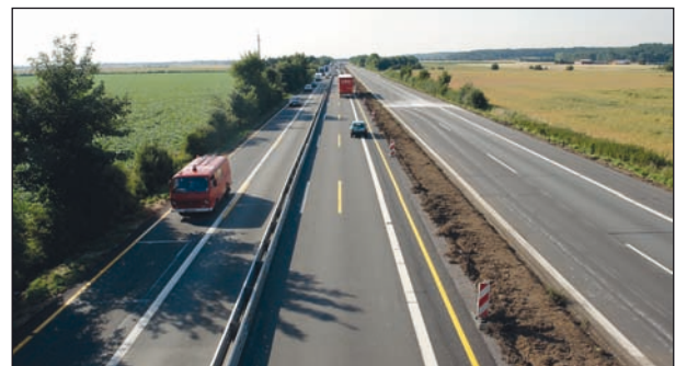
Bild 47: Innenbereich einer 4s+0-Verkehrsführung
