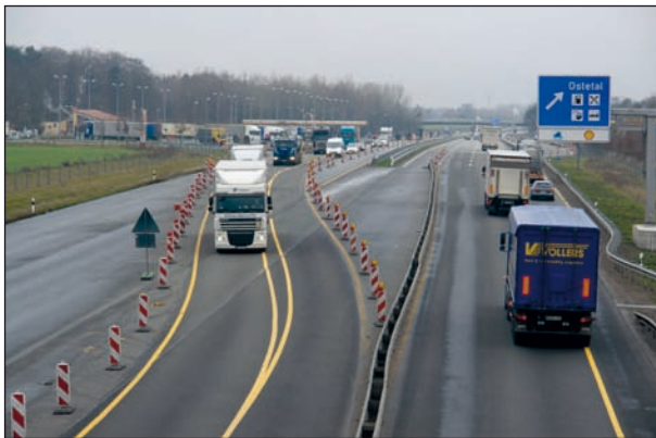
Bild 43: Überleitung mit Trennlina
