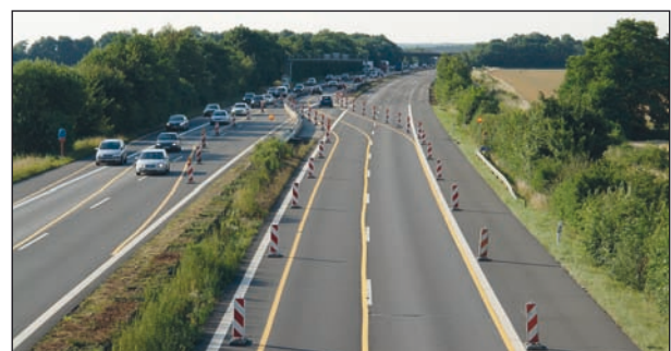
Bild 48: Überleitung in eine 4s+0-Verkehrsführung
