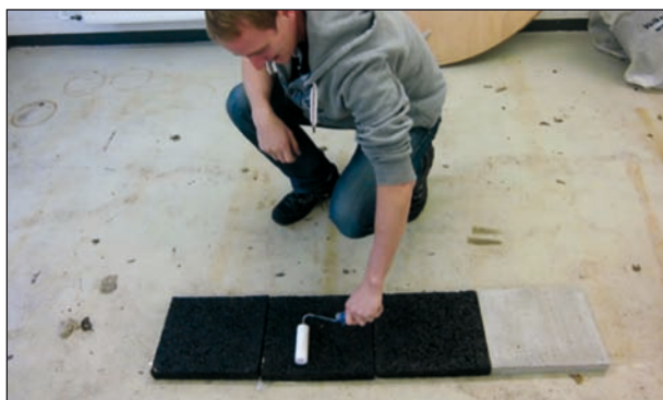
Bild 54: Aufbringen des Primers mit Lammfellrolle
