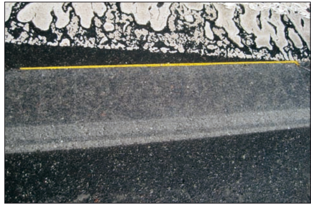
Bild 1: Geweberückstände auf der Fahrbahn nach Demarkierung
