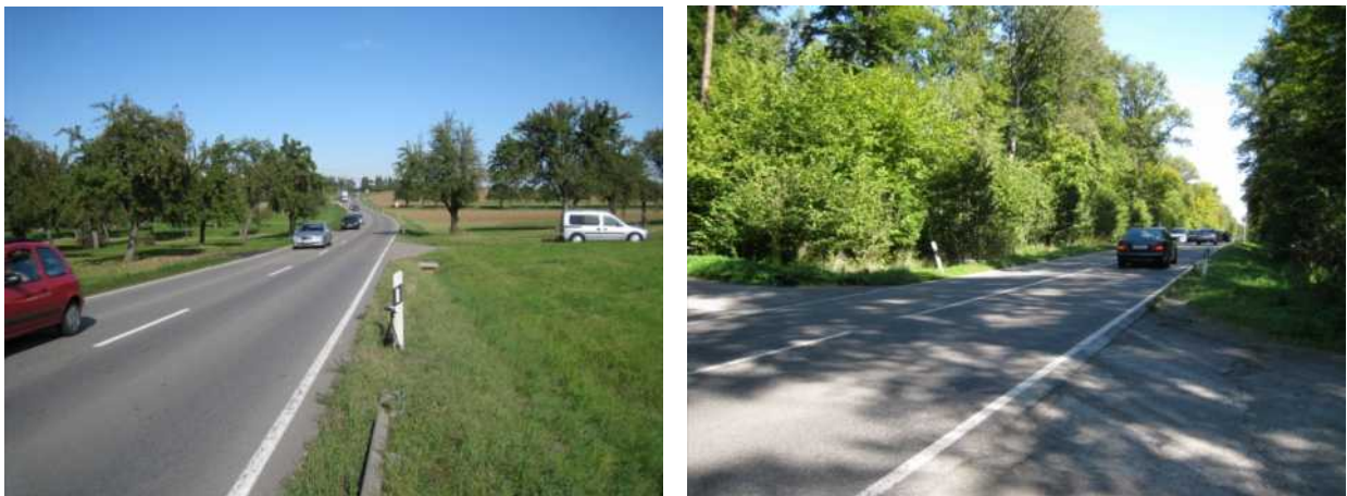
Bild 4-2: Ansichten der Messstrecke (links: MQ 3, Blickrichtung Osten, rechts: MQ 2, Blickrichtung Osten)
