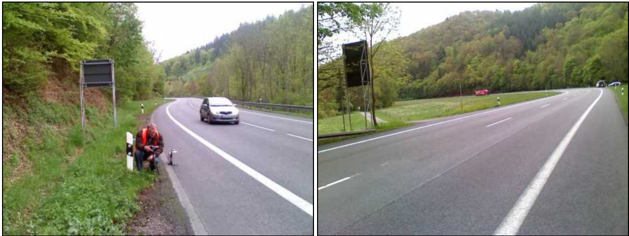
Bild 3-2: Ansichten der Messstrecke (links: MQ 1, Blickrichtung Süden, rechts: MQ 4, Blickrichtung Norden)
