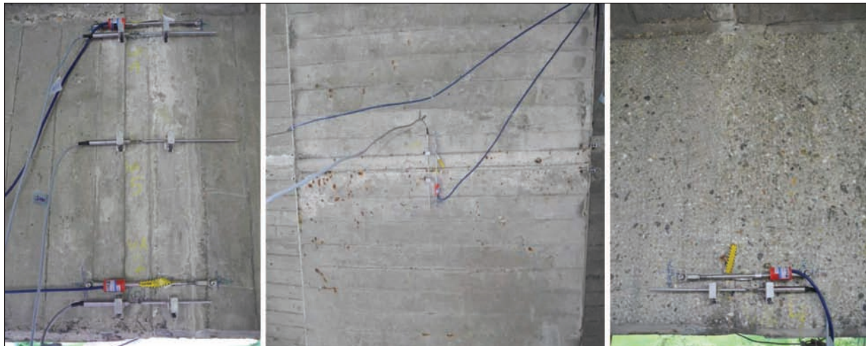
Bild 6-28: Ausgeführte sekundäre Instrumentierung am Beispiel der Koppelfugensensorik
