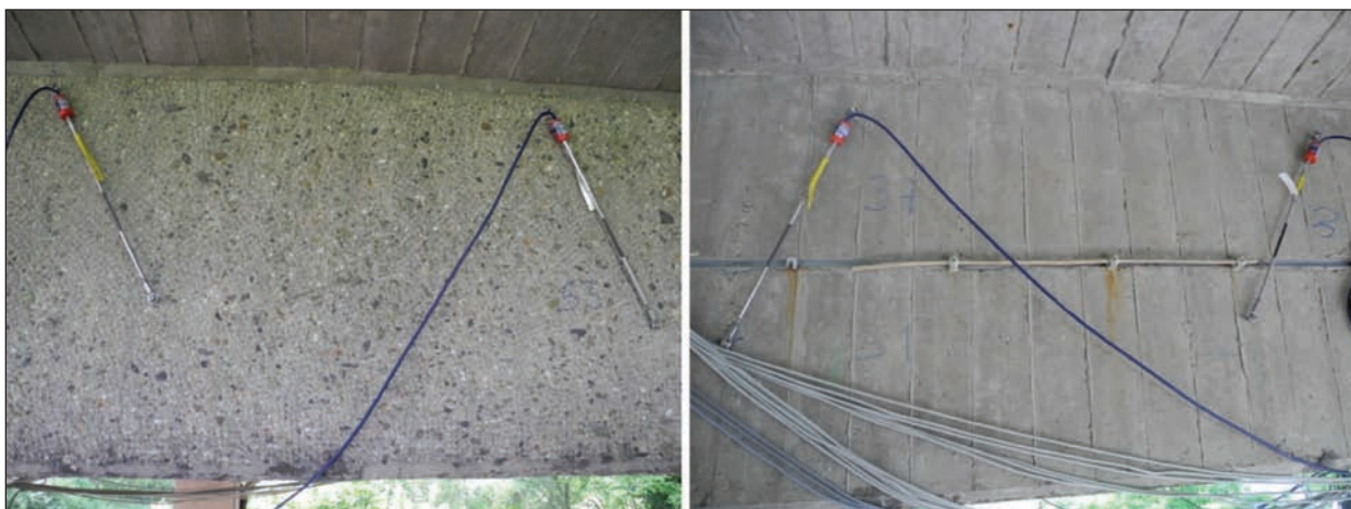
Bild 6-16: Ausgeführte primäre Sensorik als Kompensationsmaßnahme für das Schubdefizit (Position 1), links: an der Stegaußenseite, rechts: an der Steginnenseite
