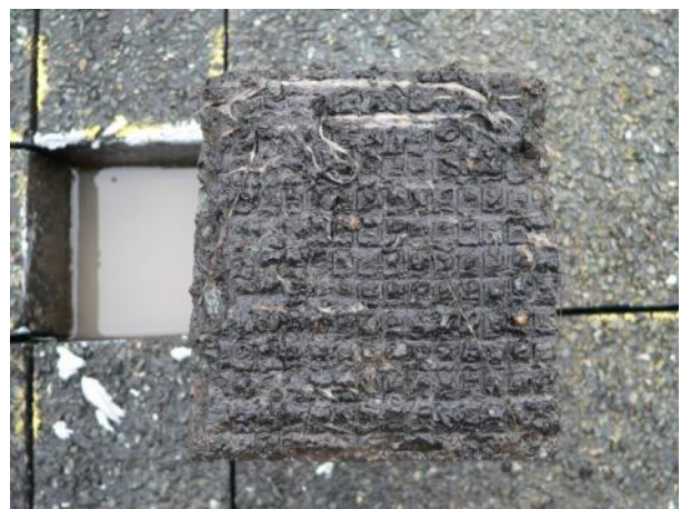
Bild 33: Verbundversagen zwischen der Schutzschicht und der Pufferschicht in Höhe des Vlieses, Prüfkörper 100 mm x 100 mm
