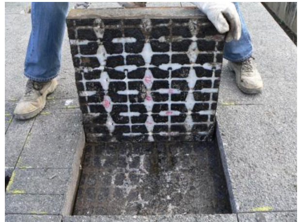
Bild 26: Testfeld A, Unterseite und Unterlage Prüfkörper 500 mm x 500 mm
