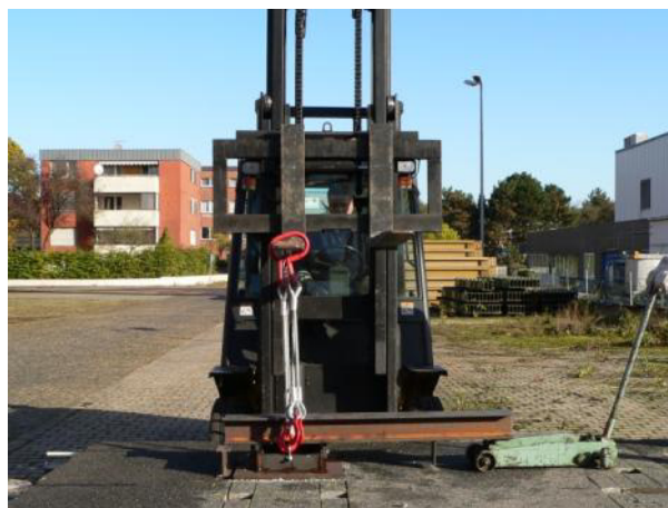
Bild 15: Abreißversuch mit hydraulischem Wagenheber und Gabelstapler (Prüfkörper 500 mm x 500 mm)
