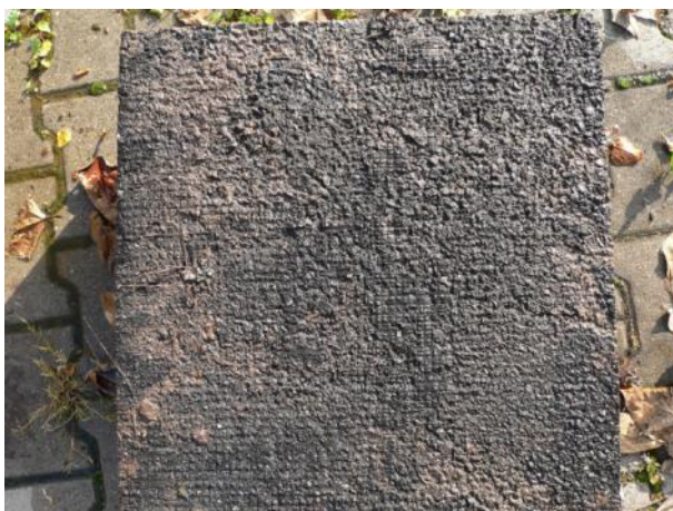
Bild 36: Verbundversagen zwischen der Schutzschicht und der Pufferschicht in Höhe des Vlieses, Prüfkörper 500 mm x 500 mm
