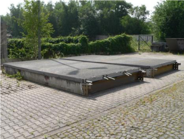
Bild 4: Fahrbahntafeln im ausgebauten Zustand im Brückenlager Willich-Schiefbahn (links beheizbarer Belag)
