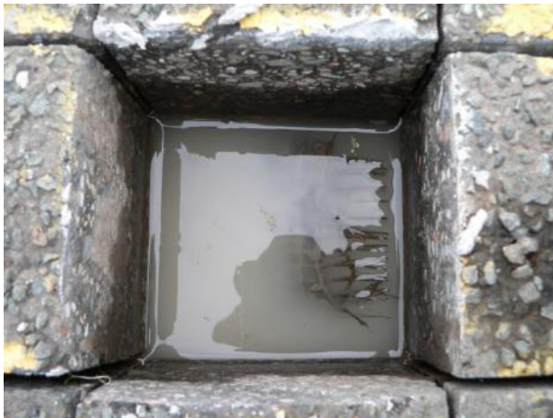
Bild 35: Verbundversagen zwischen der Schutzschicht und der Pufferschicht in Höhe des Vlieses, Ansicht Unterlage, Prüfkörper 100 mm x 100 mm
