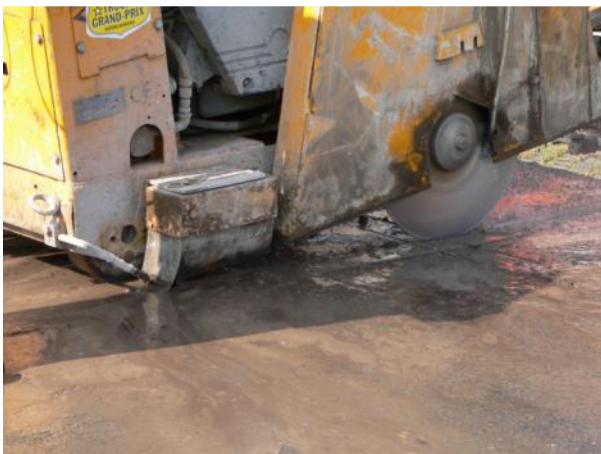
Bild 8: Schneiden der Prüfkörper
