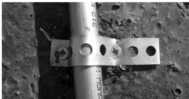
Bild 51: Befestigung der Rohre durch zugeschnittenes Lochband und Schrauben
