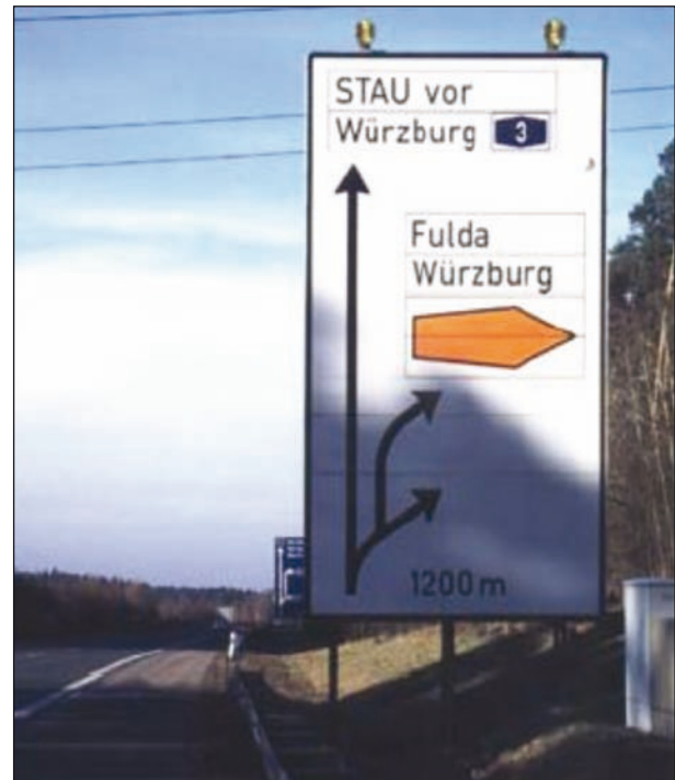
Bild 2-1: Additiver Wechselwegweiser
