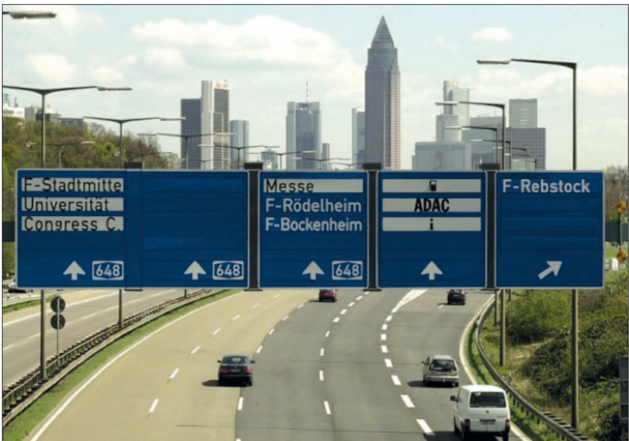
Bild 2-2: Substitutiver Wechselwegweiser
