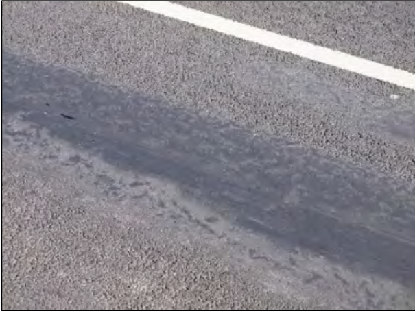
Bild 20: Beispiel einer Bindemittelanreicherung
