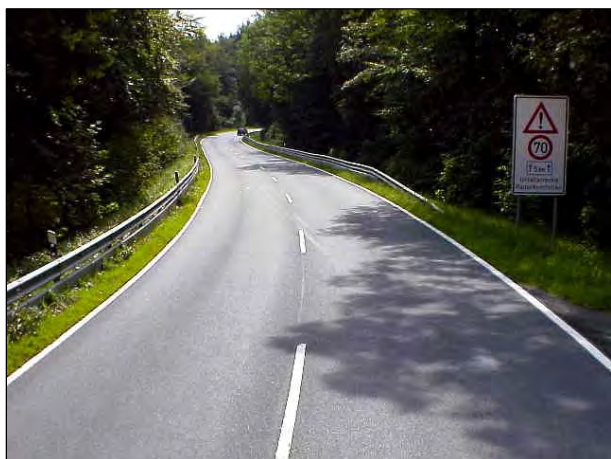
Bild 24: Umgesetzte Maßnahmen auf der B 62
