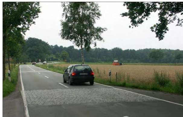
Bild 7: Beispiel einer „künstlichen“ Unebenheit im Längsprofil
