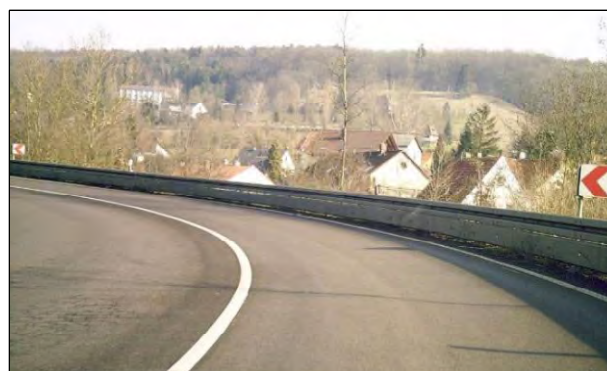
Bild 25: Umgesetzte Maßnahme auf der B 51
