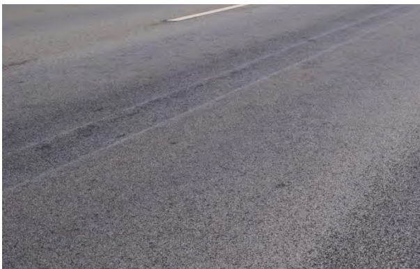
Bild 11: Beispiel einer Unebenheit im Querprofil
