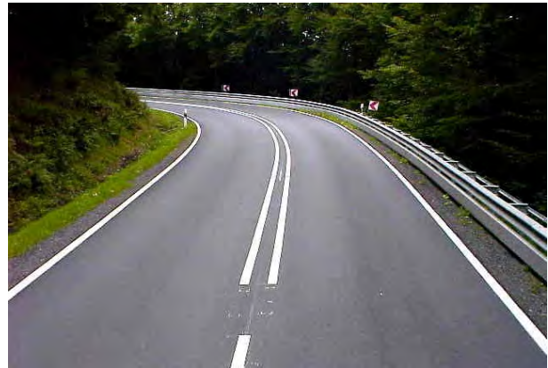
Bild 26: Umgesetzte Maßnahmen auf der B 508
