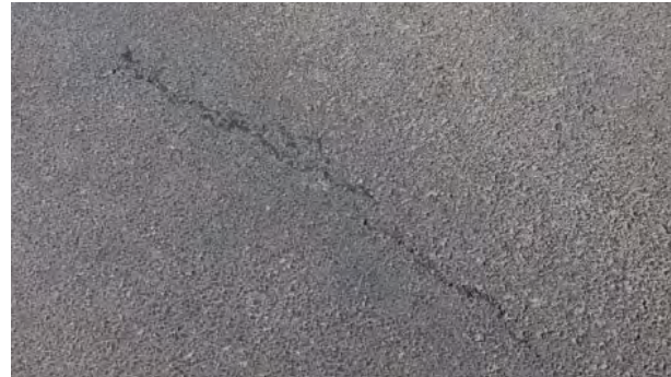
Bild 16: Beispiel eines Netznisses
