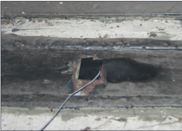
Bild 73: Dehnmessstreifen auf die Stahllaschen appliziert
