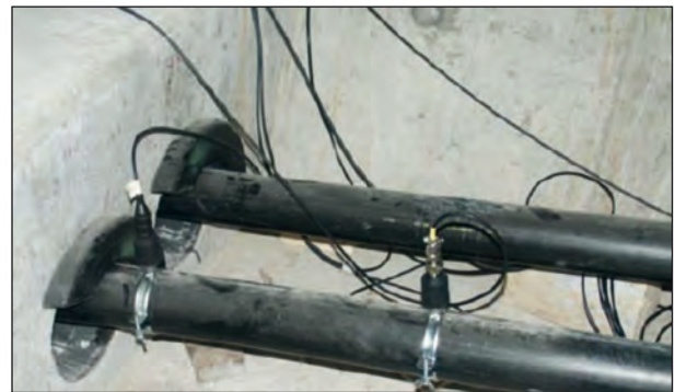
Bild 21: Sensorapplikation an einem externen Spannglied zur Schwingungsmessung [SCHO09]
