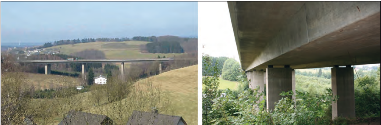
Bild 61: Fotos der Talbrücke Germinghausen
