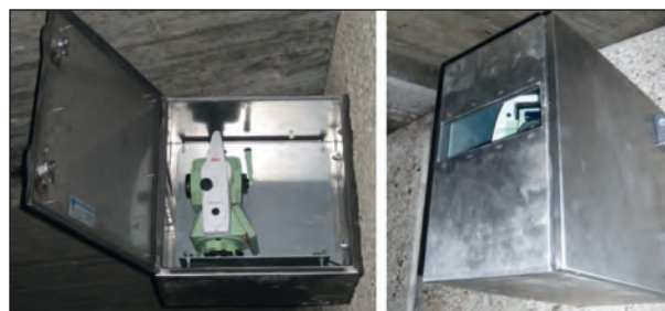
Bild 16: Verformungsmessung mittels Tachymeter an dem Widerlager einer Brücke [GLAE09]
