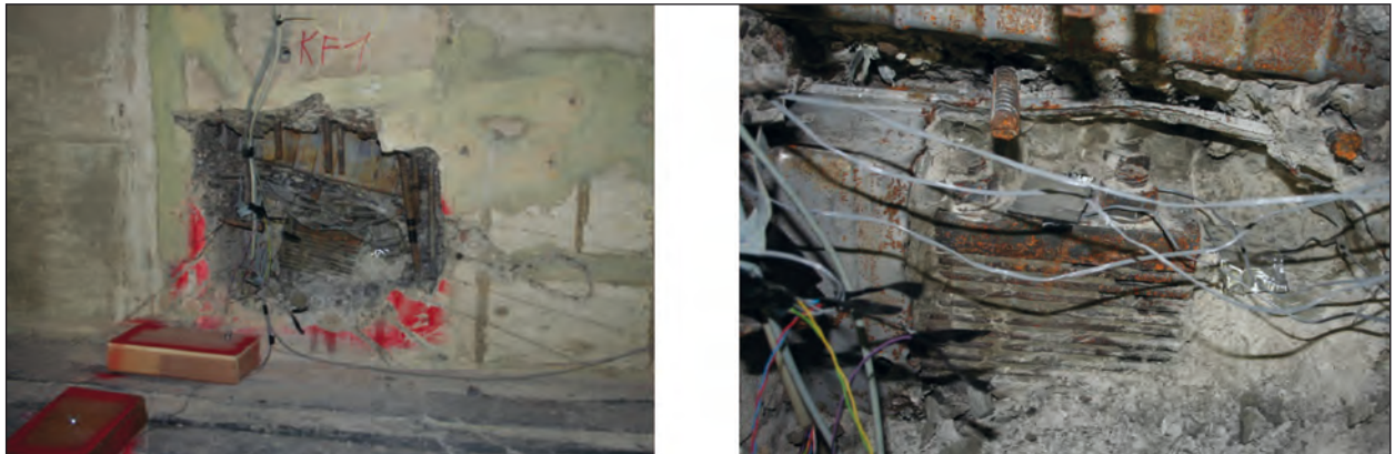
Bild 71: Freigelegte Koppelstelle (links) und auf der Verankerung applizierte DMS (rechts)
