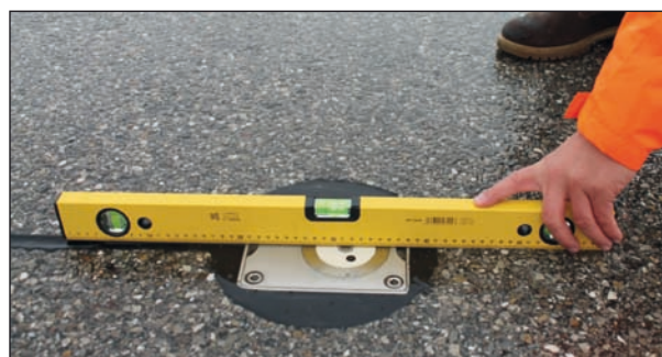
Bild 49: Kontrolle der Einbaulage eines Fahrbahnsensors mithilfe einer Wasserwaage, hier ebener Einbau eines Fahrbahnsensors
