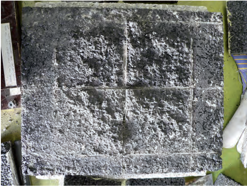
Abreißversuch, Trennung in der Deckschicht und zwischen der Deckschicht und der Schutzschicht nach Entfernen der Randstücke
