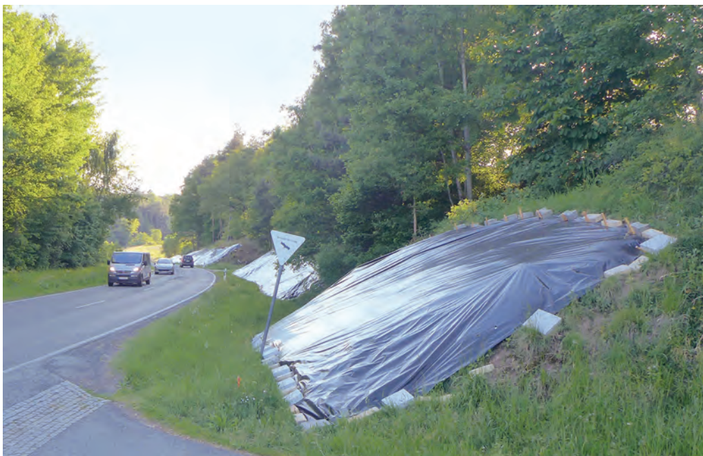
Vergrämungsmaßnahme zum Schutz der artenschutzrechtlich streng geschützten Zauneidechsen im Zuge der Vorbereitungen zum Ausbau der Straße in Bayern (Bild: Sabine Meißner, Ebelsbach)
