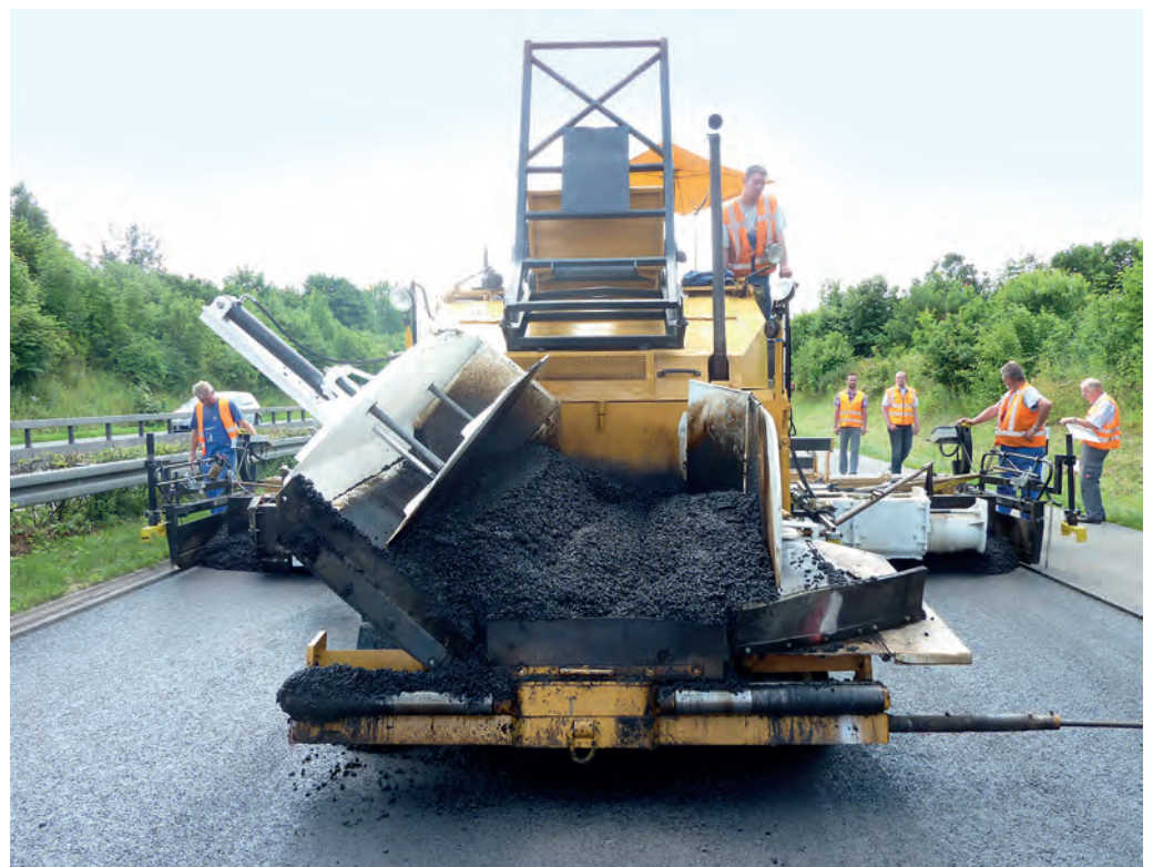
Klapp-/Schiebetechnik im Vorratskübel zur Verhinderung des Entmischens des Asphaltmischguts
