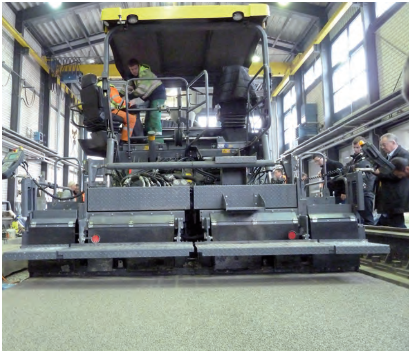
Einbau des offenporigen Betons in eine Großversuchsanlage der BAST
