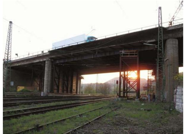
**Bild 2** Ansicht der zu untersuchenden alten Brücke mit Abfanggerüst und Treppenturm (Fahrtrichtung Bremen)
