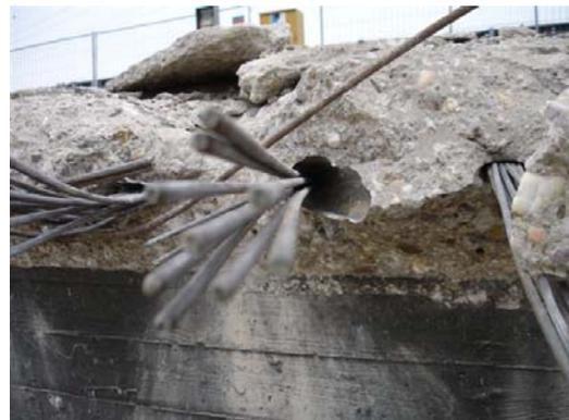
**Bild 3** Querspannglieder der Richtungsfahrbahn Köln
