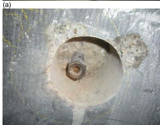
**Bild 57** (a) Entnahmestelle BK9; (b) Freigelegter metallischer Reflektor an der Bohrkernentnahmestelle BK9.
