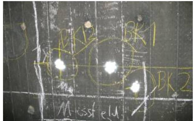
**Bild 54** Entnahmestelle an der Unterseite der Fahrbahnplatte mit eingezeichneter Lage des Querspannglieds
