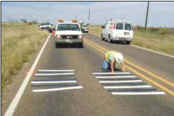
**Bild 45:** Aufbringung vorgefertigter Rüttelstreifen in den USA
