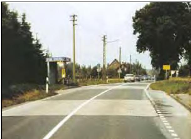
**Bild 11:** Veränderung der Fahrbahnoberfläche an der Ortseinfahrt Wegberg-Rickelrath (L3) durch Pflasterungen (akustische Bremse) (MAIER, 1991)
