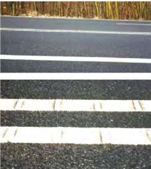
**Bild 29:** Profilierte Mittelmarkierung (MORSCHHÄUSER, 1999)
