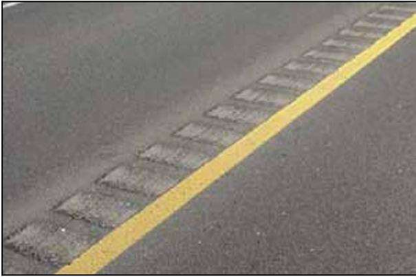
**Bild 27:** Gefräste "Rüttelstreifen" am Fahrbahnrand eines US-Highways
