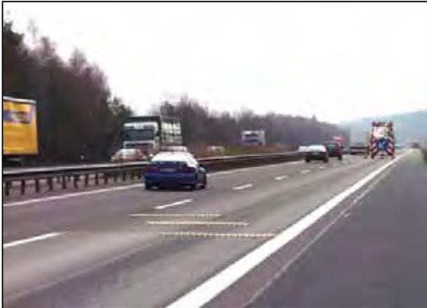
**Bild 23:** Einsatz von Warnschwellen bei einer Arbeitsstelle kürzerer Dauer auf dem rechten Fahrstreifen (STEINAUER et al., 2004)
