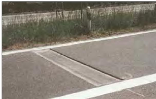
Bild 19: Ausführungsdetail Variante 2 – gefräster Rüttelstreifen (BRILON, 2001)
