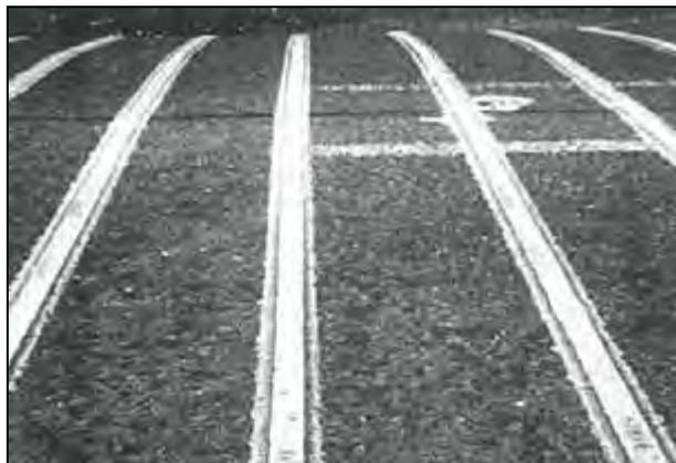
**Bild 34:** Rüttelstreifen aus thermoplastischem Material bei Hawley Village (WEBSTER, 1993)
