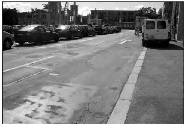
Bild 7.3: Blick in die Turmstraße (Abschnitt 12). Zur Lage des Straßenabschnittes siehe Bild 4.6
