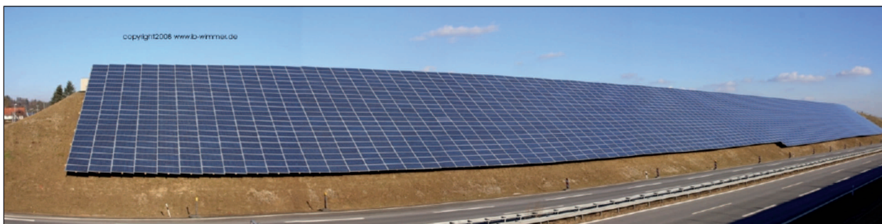
Bild 3: PV-Anlage an einem Lärmschutzwall an der A 96 (Quelle: ib wimmer)
