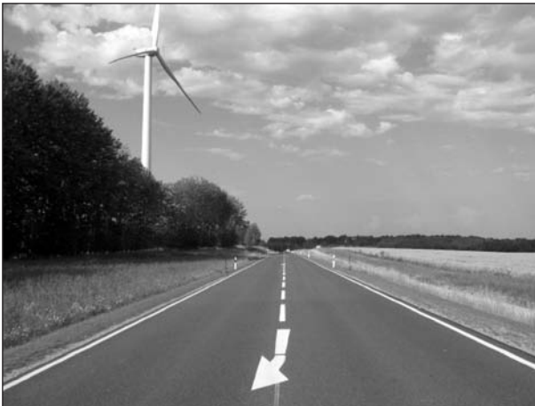
Bild 5.1: Versuchsstrecke, Blick Richtung Kamenz (Norden)
