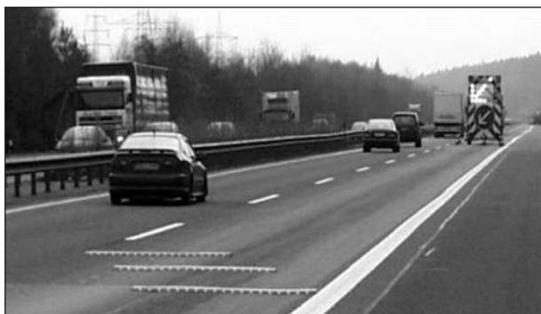
**Bild 7:** Einsatz von Warnschwellen auf dem rechten Fahrstreifen [STEINAUER et al. (2004)]
