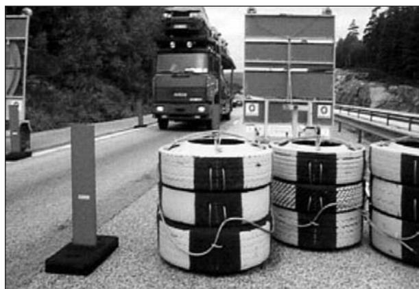
**Bild 15:** Reifenstapel als stationärer Aufprallschutz (Schweden) [VÄGVERKET (1998)]
