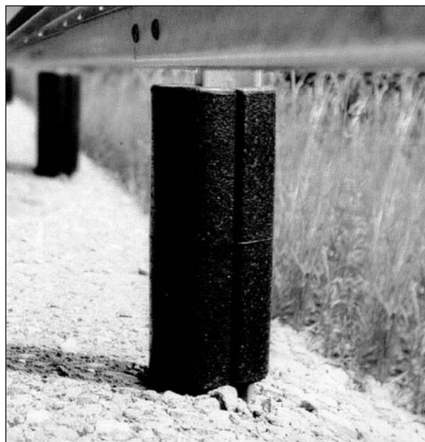
Bild 8-6: Fertig montierte SPU; Quelle [19]
