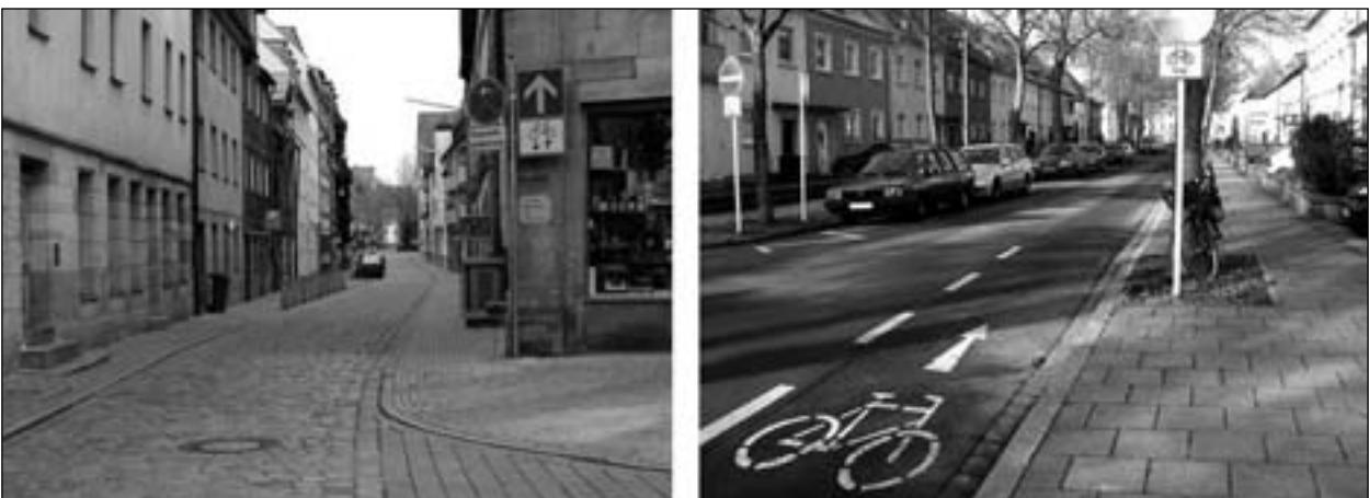
Bild 5.11: Freigabe des Radverkehrs gegen die Einbahnrichtung ohne Abweichungen von der VwV-StVO, links: nur Beschilderung, rechts: Beschilderung und Markierung im Einfahrtbereich
