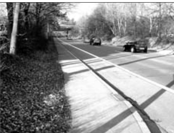
Bild 5.7: Radfahrstreifen mit und ohne Abweichungen von der VwV-StVO, links: abweichende Markierung, rechts: StVO-konformer Radfahrstreifen
