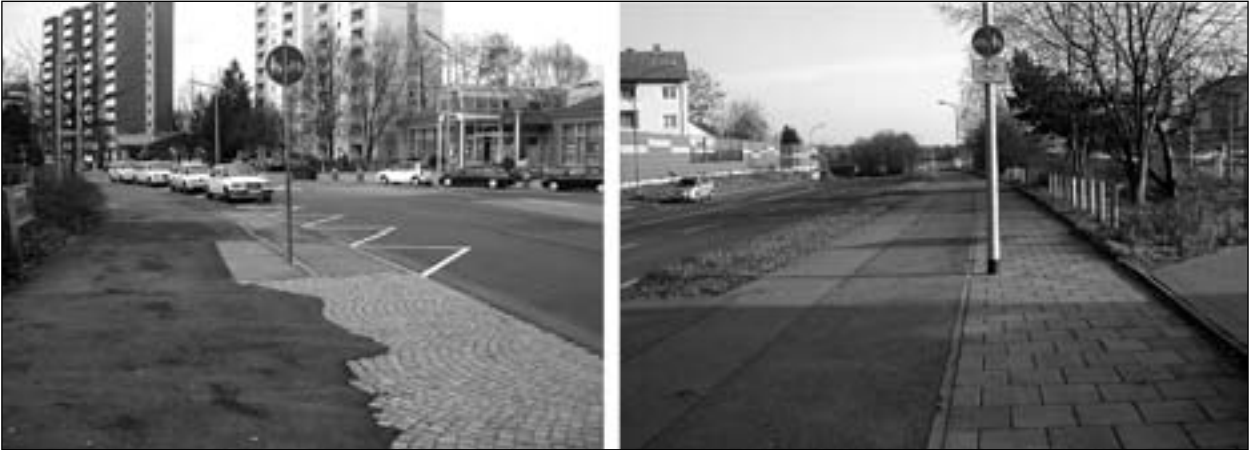
Bild 5.9: Benutzungspflichtige Radwege mit und ohne Abweichungen von der VwV-StVO, links: Zweirichtungsradweg mit zu geringer Breite und baulichen Mängeln, rechts: StVO-konformer Zweirichtungsradweg
