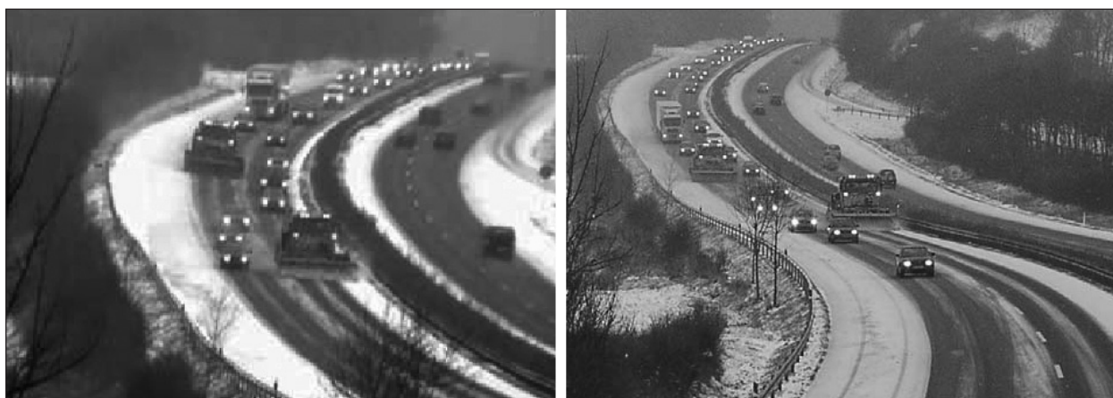
Bild 19: Staffelfräumung mit großem Abstand der Winterdienstfahrzeuge an der A 5 im Bereich der TR Berfa am 04.01.2004 [Videobilder]
