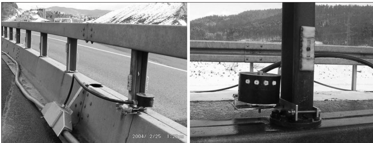
Bild 26: Befestigung eines Sprühkopfes an der Stahlschutzwand und Ausstattung des Sprühkopfes mit 3 Normalstrahldüsen und einer Breitstrahldüse
