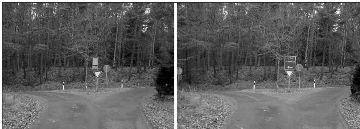
Bild 46: Betriebsumfahrt mit Klappbeschilderung für Umleitungsstrecken
