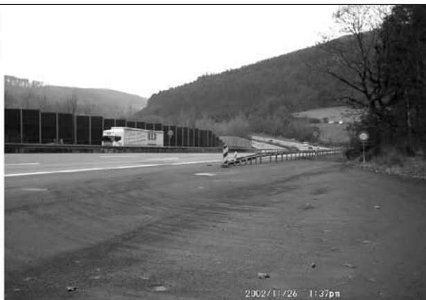
Bild 45: Betriebsumfahrt mit rechtwinkligem Anschluss (links) und schiefwinkligem Anschluss (rechts)
