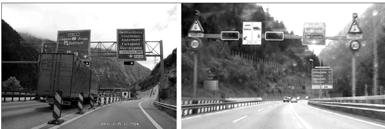
Bild 53: Regelung am Tropfenzählersystem durch eine Lichtsignalanlage (links) und Schilderbrücke mit LSA, auch eingesetzt zur temporären Fahrbahnsperrrung bei der Winterregelung (rechts, Videobild)
