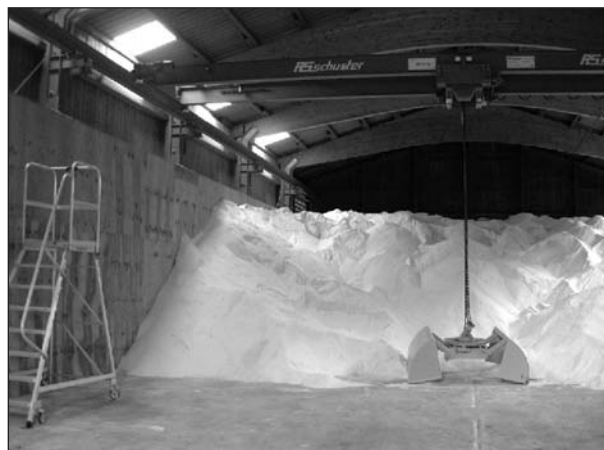
Bild 42: Hallenkran mit Bedienpodest des Stützpunktes Americh (AM Montabaur)
