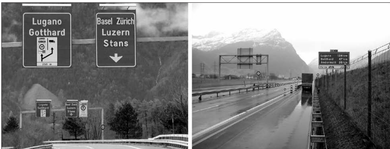
Bild 52: Vorsignalisation Warteraum Axen (links) und Einfahrt in den Warteraum Attinghausen (rechts) [Bildquelle: Verkehrspolizei Kanton Uri, Schweiz]
